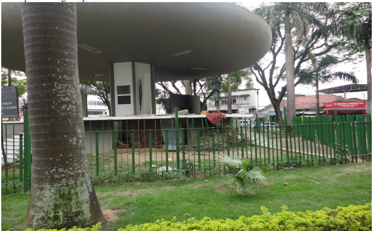
Ilustração 3 – Degradação do monumento.
