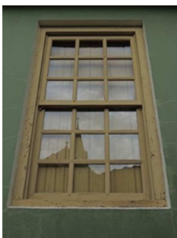
Esquadria fachada lateral Casa Pastoral
