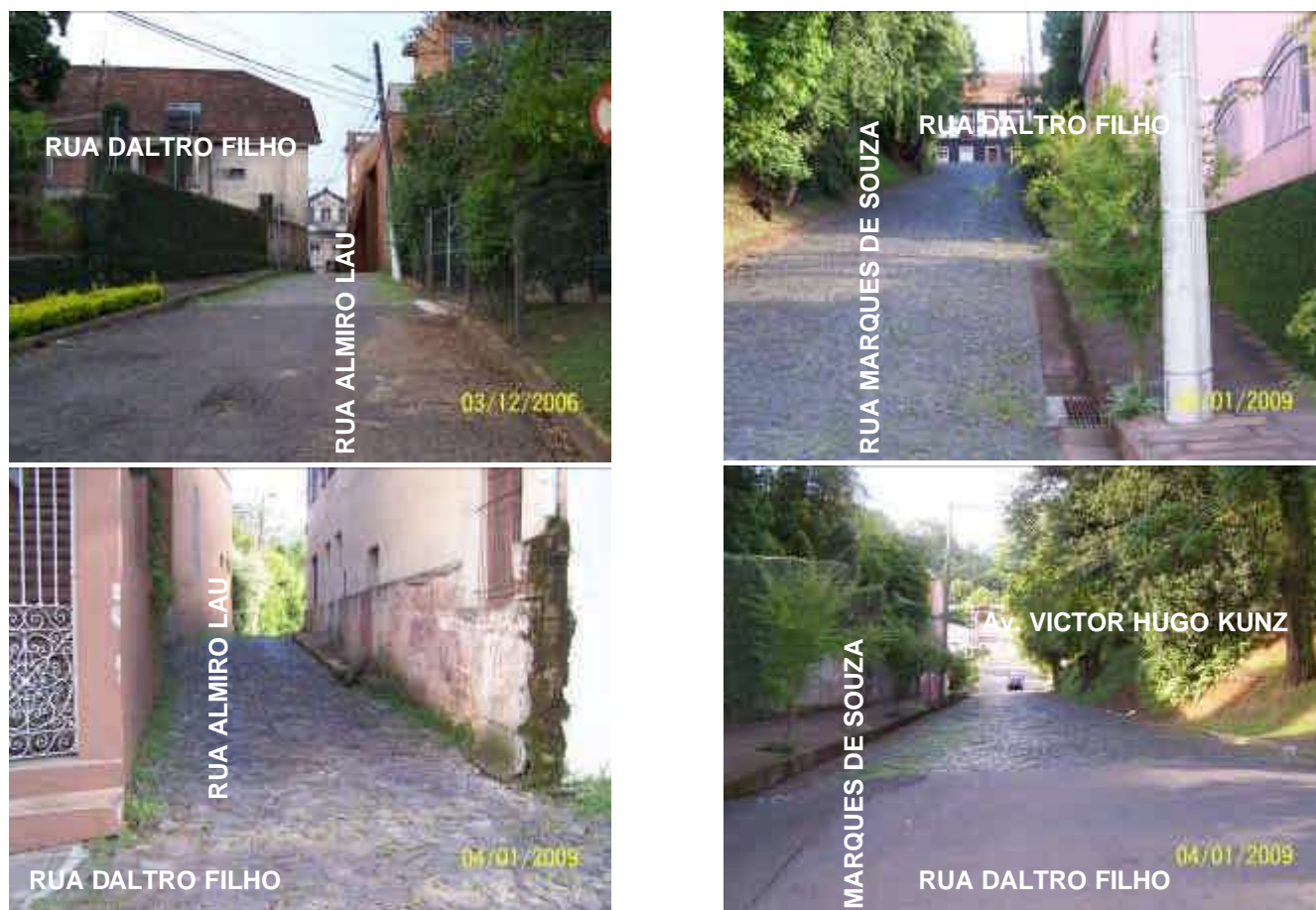
FIGURA 57 – PAVIMENTAÇÃO COM PEDRA IRREGULAR
