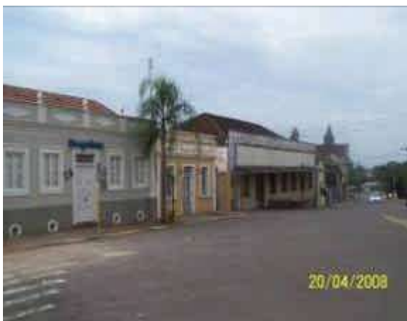
FIGURA 22 – CASA KLEY - BURGOBRÁS Rua General Daltro Filho, 800 - NH - RS Propriedade Srª Norma Beatriz Kley Fonte: foto de Markus Wilimzig. Data: 20.04.2008
