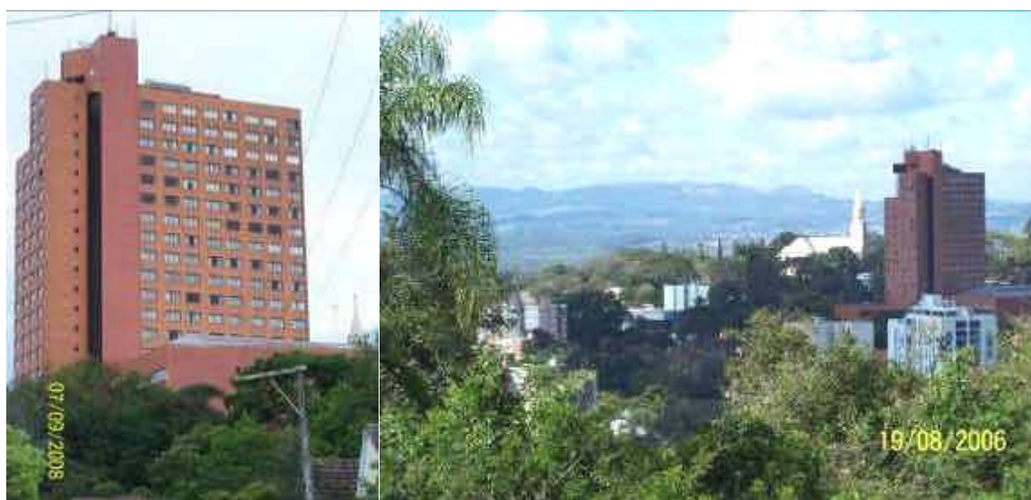
FIGURA 50 A e 50 B – EDIFICAÇÃO DO HOTEL SWAN TOWER – NOVO HAMBURGO - RS FONTE: Foto da esquerda, da autora. Data: 07.09.2008. Foto da direita, de Markus Wilimzig. Data: 19.08.2006
