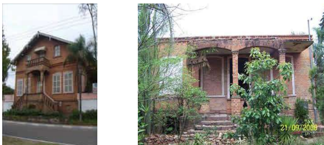
FIGURA 32 – SOLAR DOS KROEFF – CASA ACAUAN – NOVO HAMBURGO - RS FONTE: foto esquerda, antes da demolição, acervo Fundação Scheffel. Data: s.d foto direita de Markus Wilimzig. Data: 21.09.2008.
