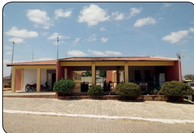
Figura 26 – Timbaúba dos Batistas - Hotel Timbaúba.
