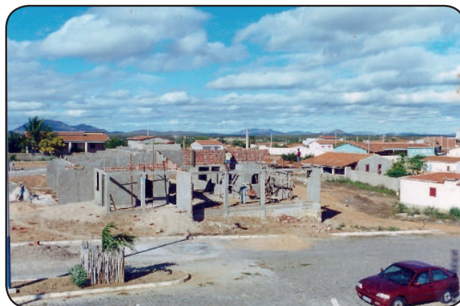
Figura 25 – Hotel Timbaúba em construção em 1998.
