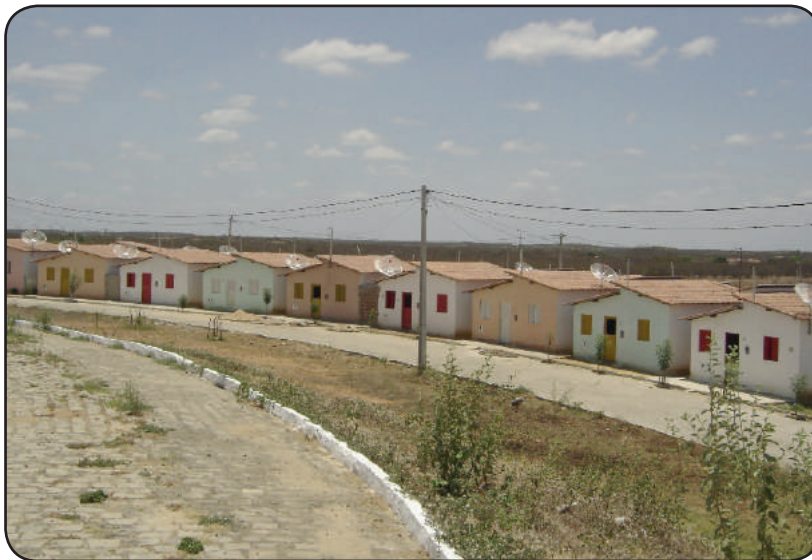
Figura 29 – Conjunto habitacional José Damasceno.
