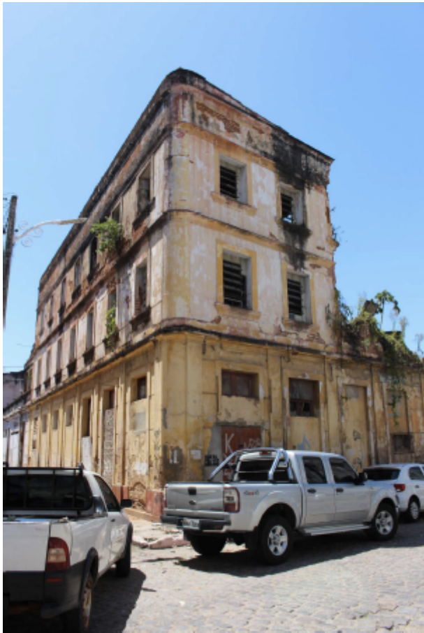
Edifício Arpége / Galhardo – fachada frontal e lateral esquerda.
