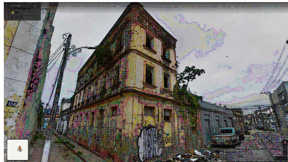
IMAGEM LATERAL EDIFICAÇÃO RC- 161 (AGO. DE 2019)
