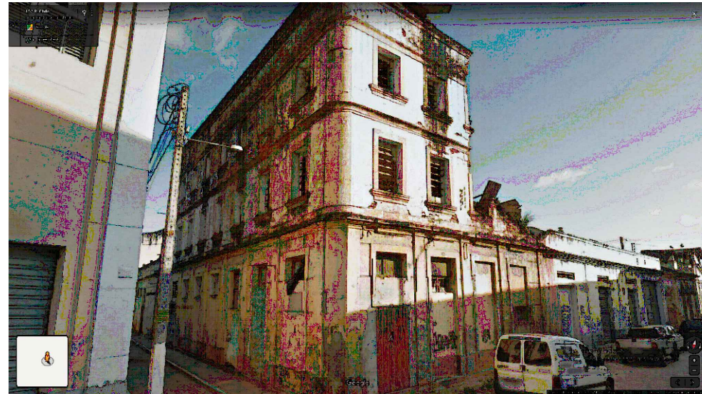
IMAGEM LATERAL EDIFICAÇÃO RC-161 (NOV. DE 2011)
