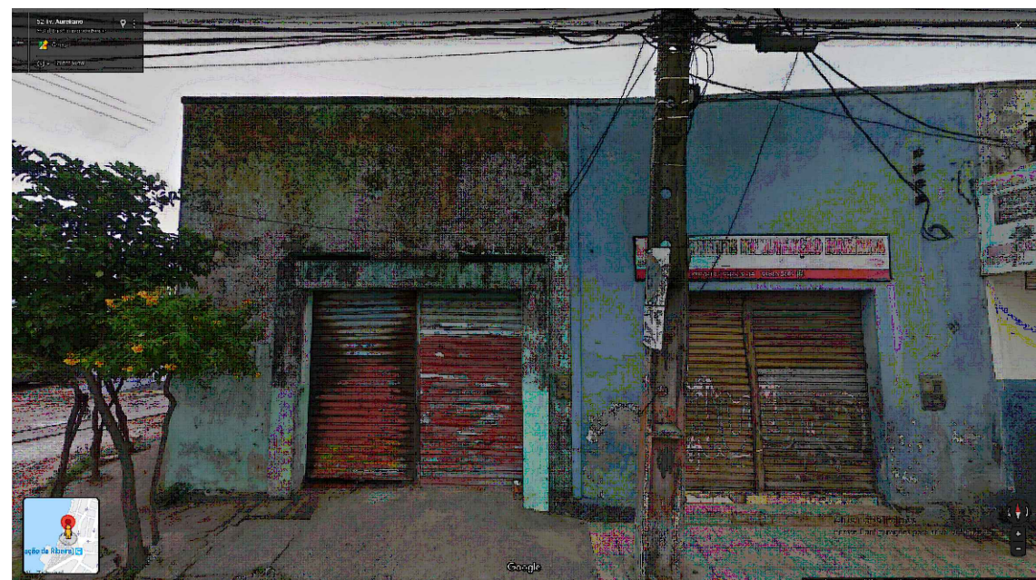
IMAGEM LATERAL EDIFICAÇÃO RC-255 (AGO. DE 2019)
