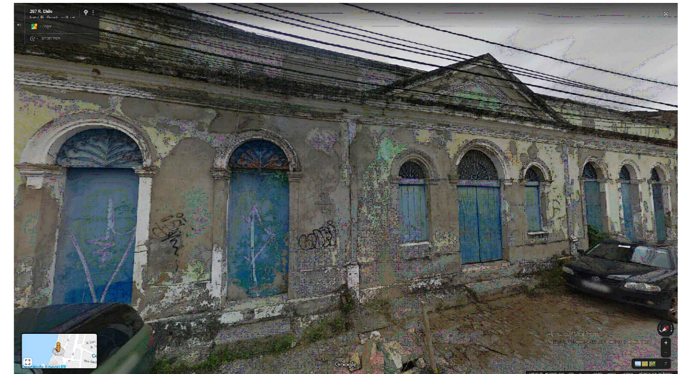
IMAGEM FRONTAL EDIFICAÇÃO RC-406 (AGO. DE 2019)
