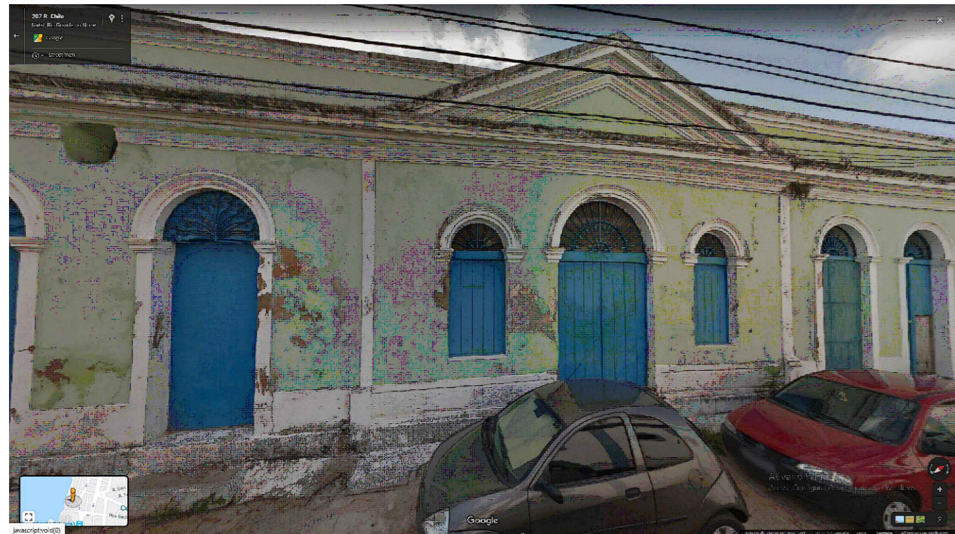
IMAGEM FRONTAL EDIFICAÇÃO RC-406 (NOV. DE 2011)
