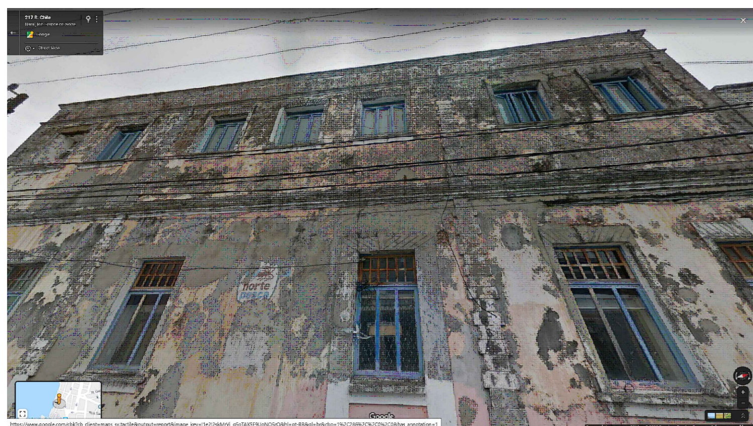
IMAGEM FRONTAL EDIFICAÇÃO RC-456 (AGO. DE 2019)
