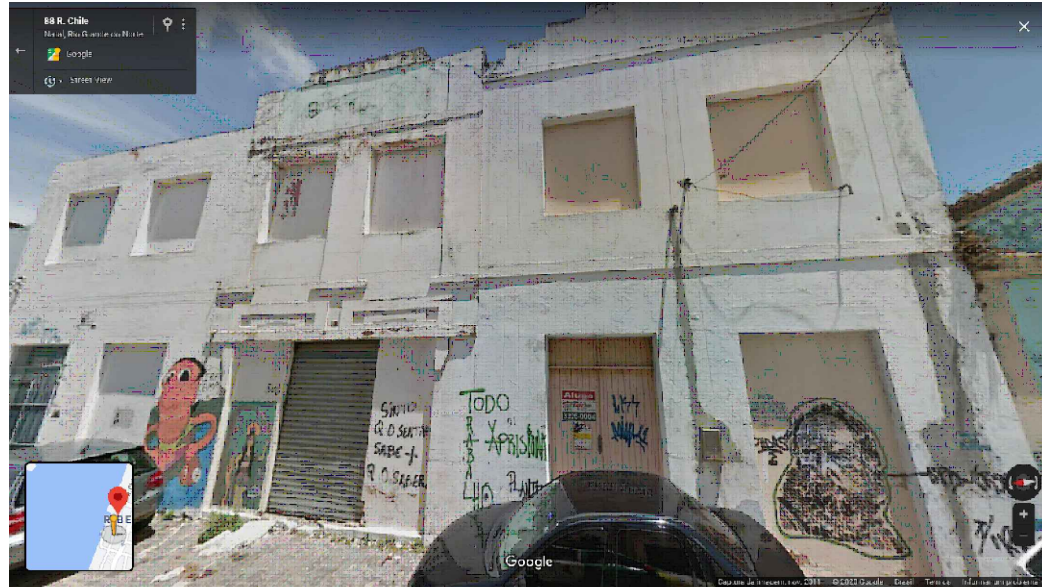
IMAGEM FRONTAL EDIFICAÇÃO RC-S_N-02 (NOV. DE 2011)
