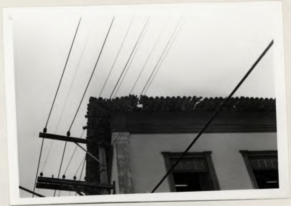
ESTADO DE CONSERVAÇÃO DO TELHADO: 1- VISTA POSTERIOR
