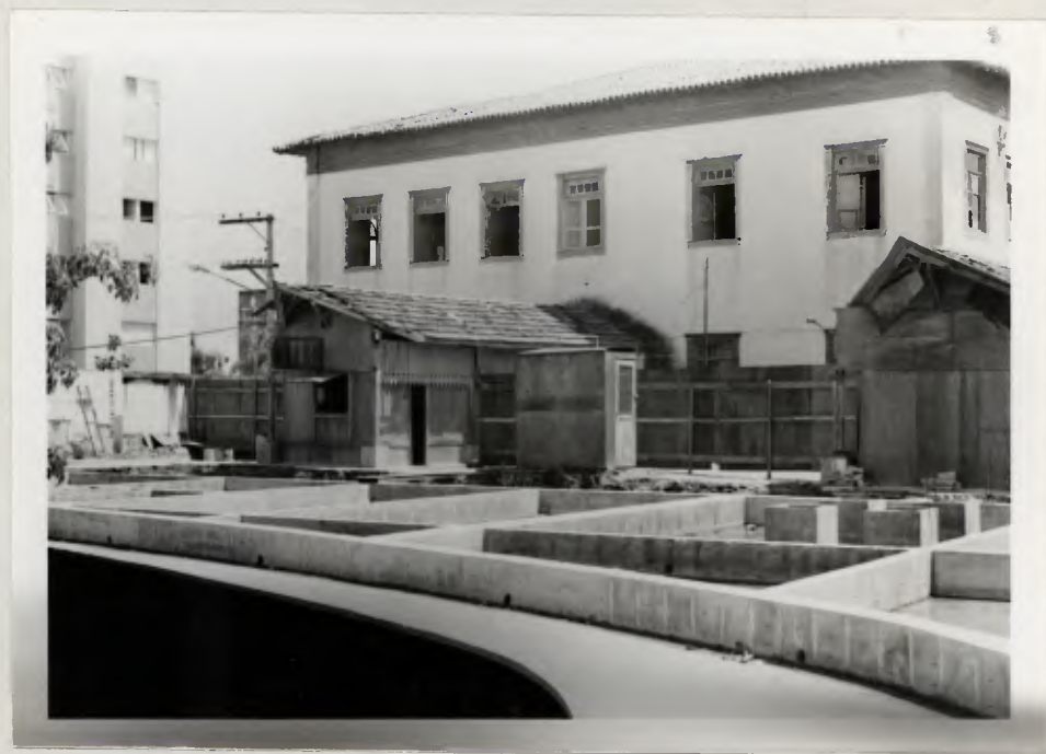
VISTA POSTERIOR DO BEM TOMBADO MOSTRANDO A NOVA CONSTRUÇÃO COM UMA LAJE JÁ CON- CRETADA.
