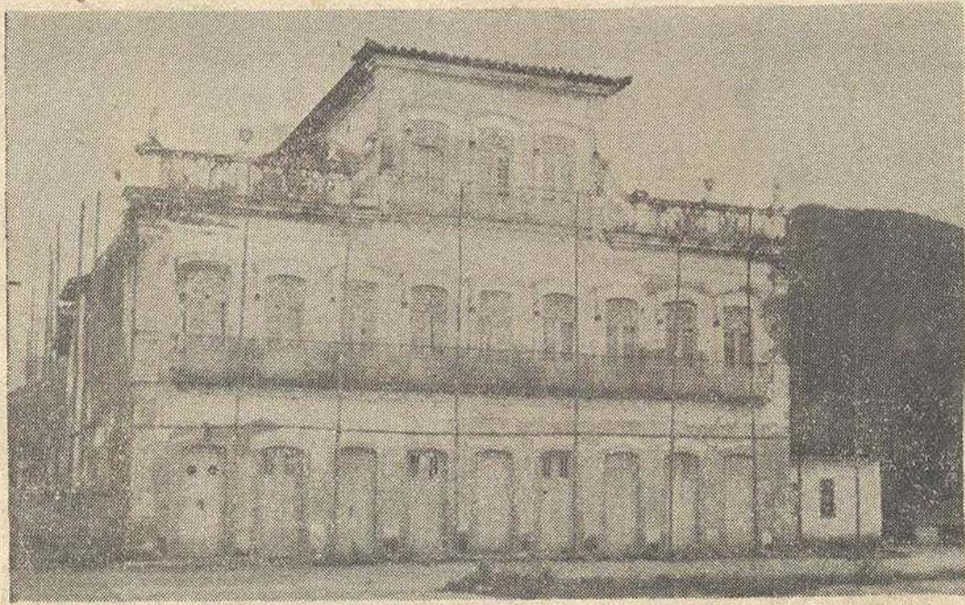
O sobrado construído por Baltazar Fortes e onde se hospedou D. Pedro II, recorda a época do fastigio de Ubatuba. Pertence hoje à família Guisard. Ainda não foi tombado pelo DPHAN nem pelo serviço congênere estadual. É uma das atrações turísticas da cidade.
