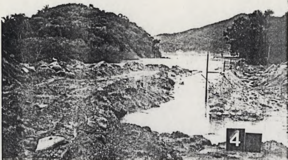
Aterro de mangue / construção de estrada - Peçé - Pta de Iporanga
