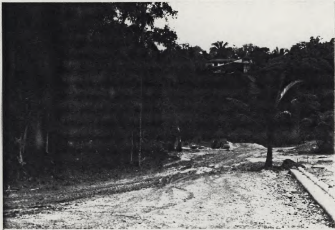
9) Detalhe do arruamento em obra.
