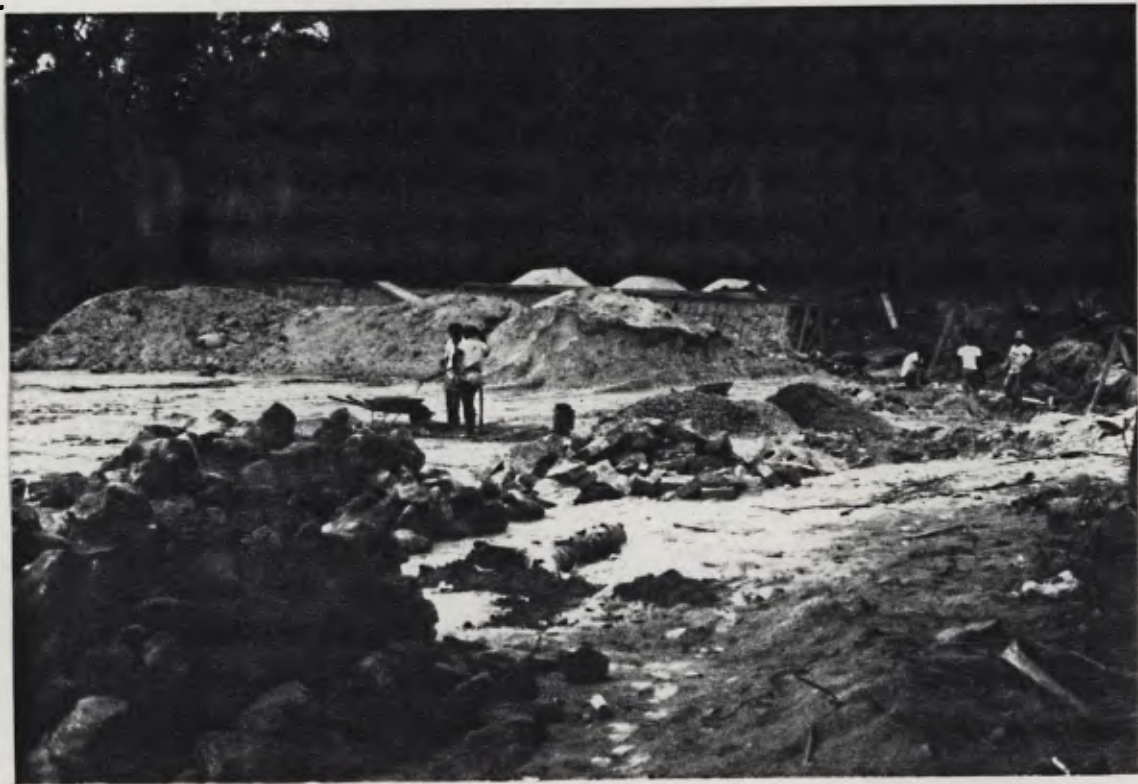
11) Detalhes de obras de construção de muros na Praia dos Pinheiros.
