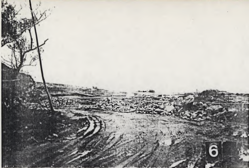
Aterro de mangue/abertura de estrada - Peçé - Ponta de Iporanga
