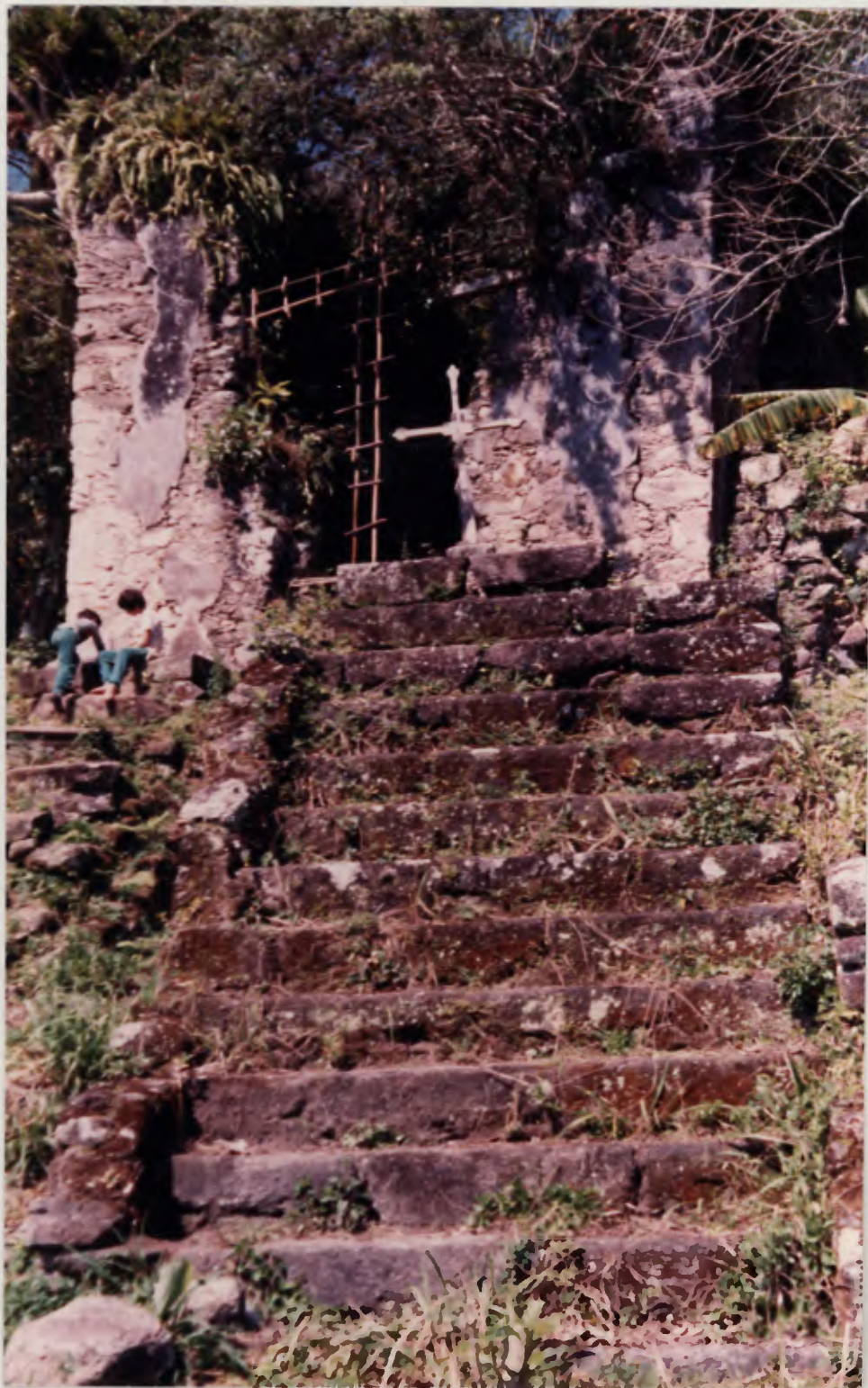
- Ruínas da Igreja Santo Antônio de Guaibê, bem tombado pelo Condephaat e pelo SPHAN, localizado próximo à desembocadura do canal da Bertioga.
