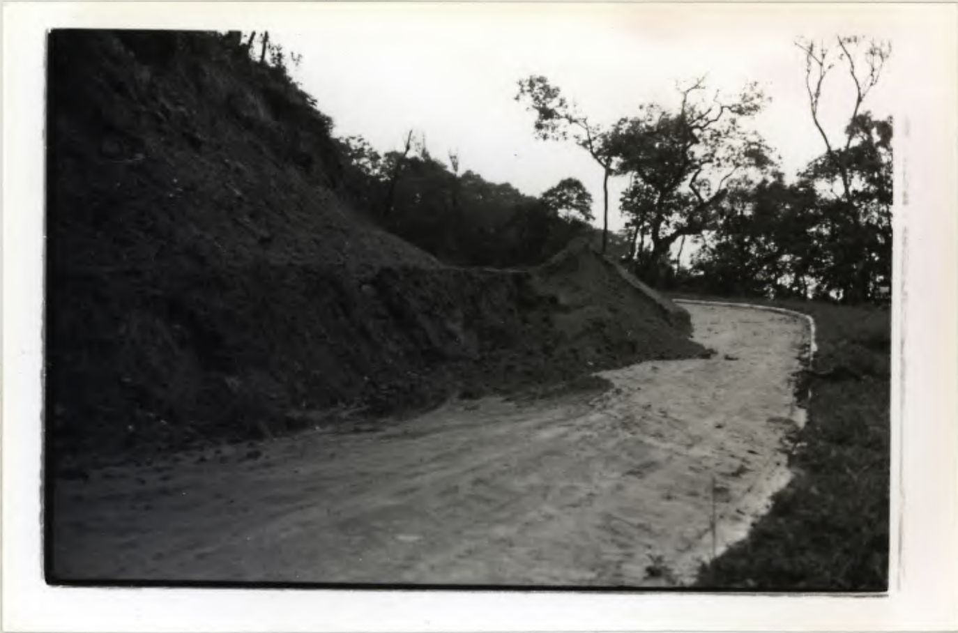
Foto nº 23 - Trecho do arruamento já aberto onde ocorreu desmatamento . desmatamento
