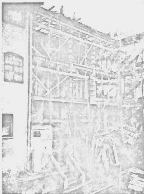
Fotos 4 e 4A -- Vistas antigas dos patamares ajardinados do quintal e das obras efetuadas em 1935.
