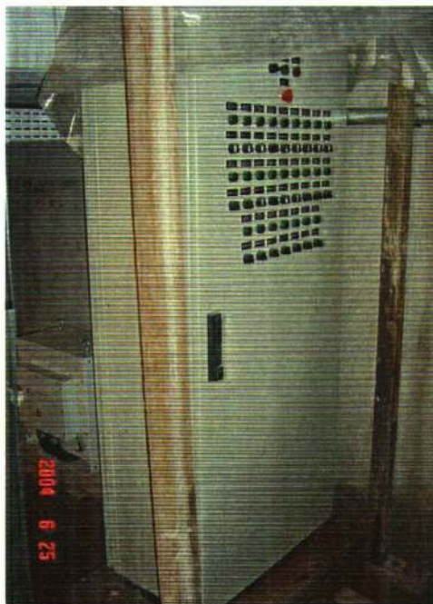
Novos quadros elétricos instalados no Reservatório Inferior
