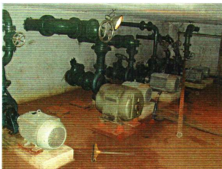
Antigas Instalações do Reservatório Inferior
