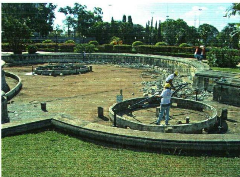
Desmontagem das instalações no chafariz
