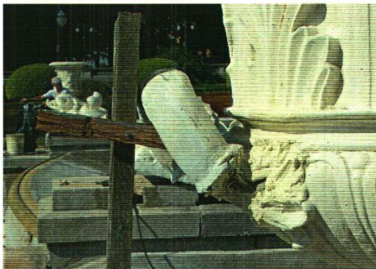
Aplicação de peças faltantes
