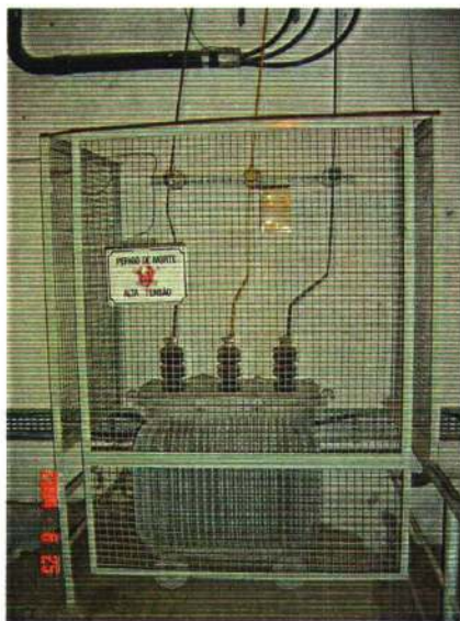
Troca do transformador do Reservatório Superior
