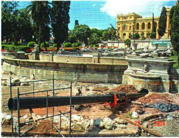
Instalação da tubulação em PEAD pelo sistema não destrutivo
