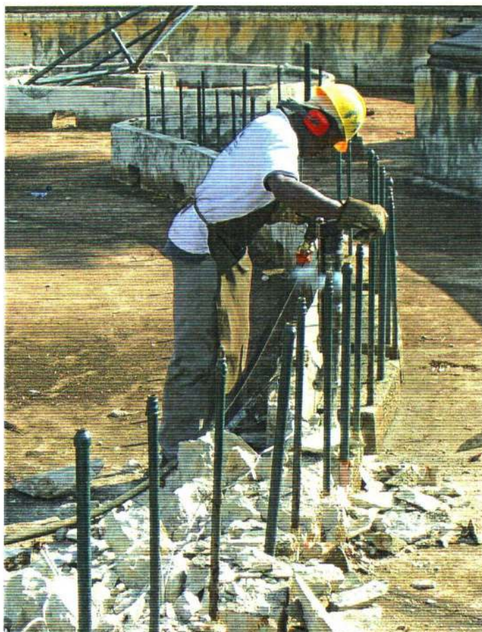
Antigas Instalações do Chafariz em processo de demolição
