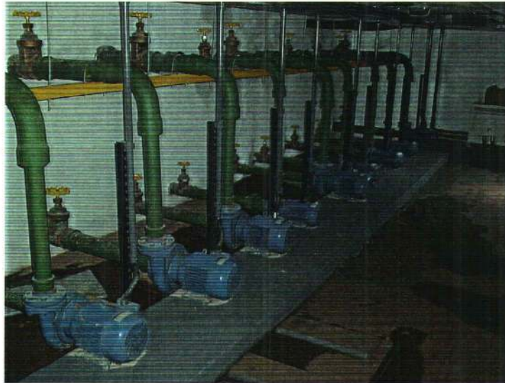
Instalações de novas bombas no reservatório Inferior
