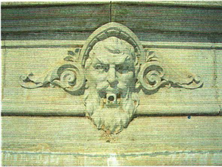
Processo de restauro
