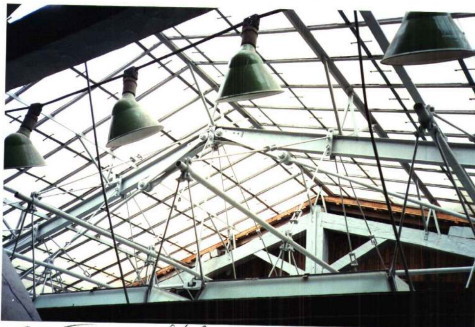
Estrutura metálica da abertura em vidro do corpo principal do edifício.
