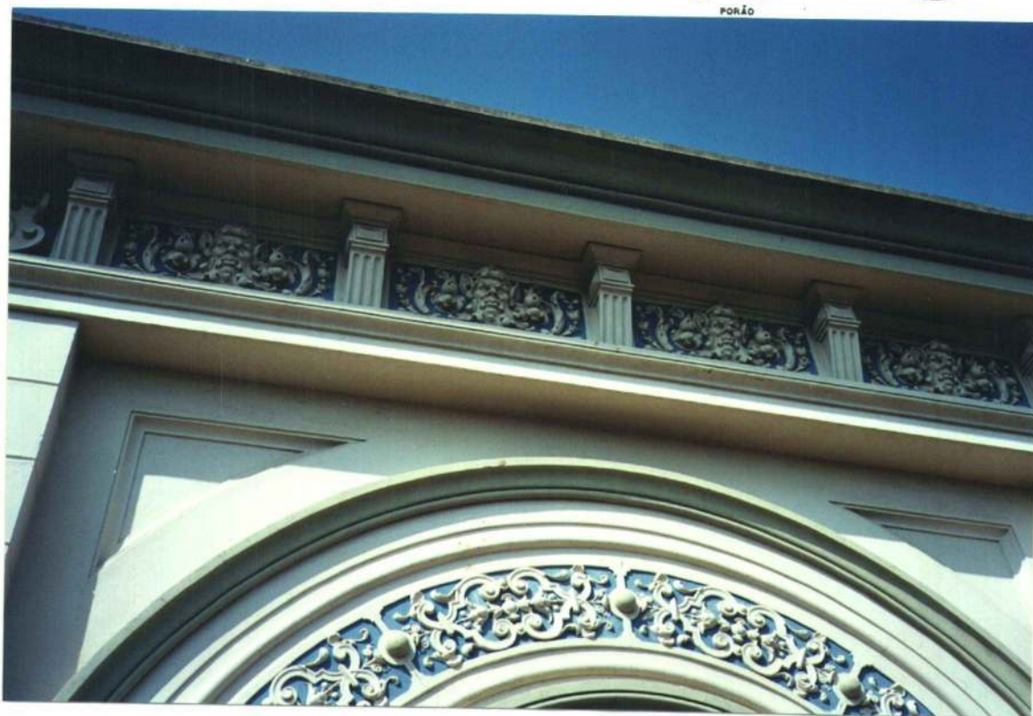
DETALHE DE ORNAMENTOS NA CIMALHA
