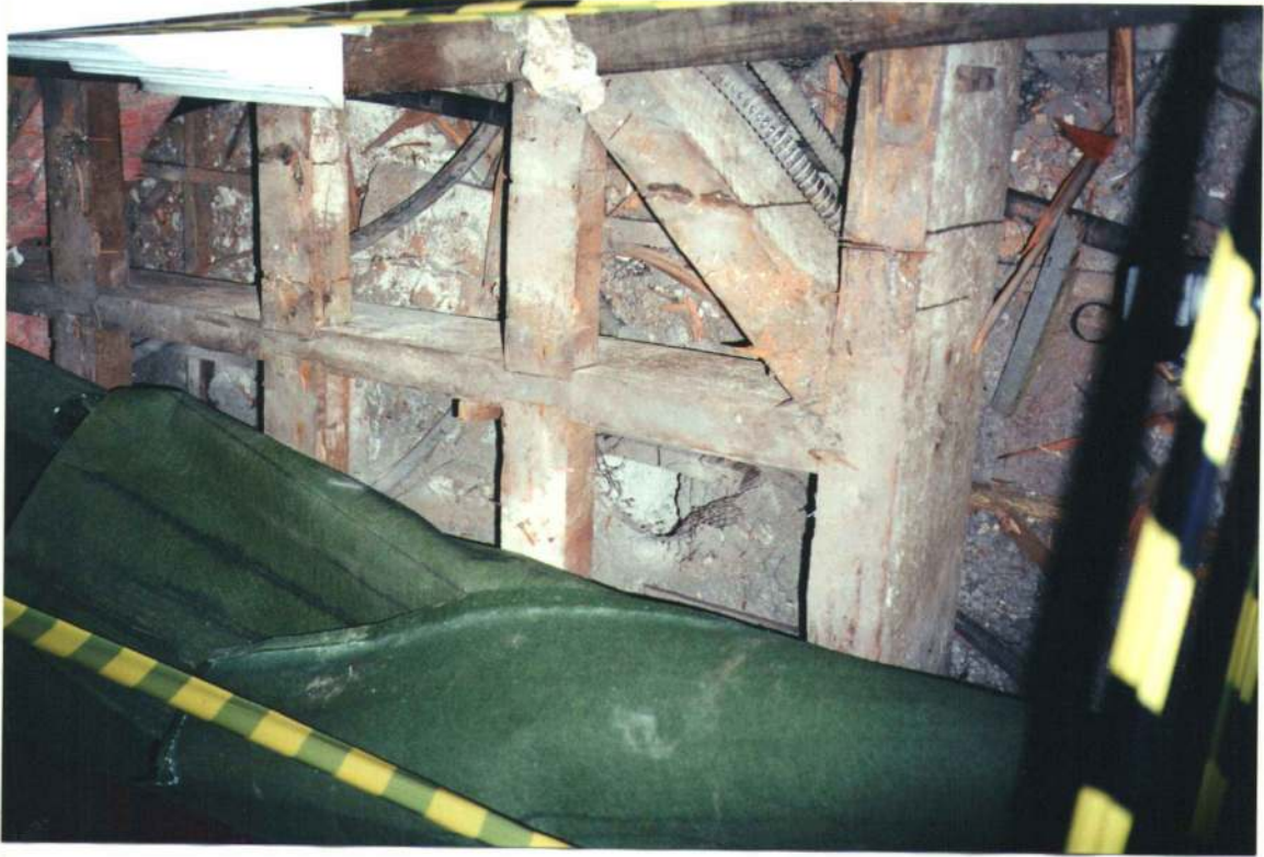
DETALHE DE PROSPECÇÃO PARA AVALIAÇÃO DOS BARROTES DO PAV. SUPERIOR.
