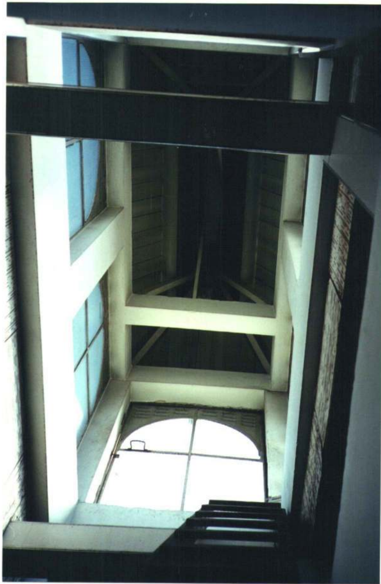
VISTA INTERNA DO LANTERNIM, SITUADO ACIMA DO SOTÃO
