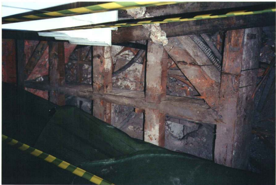
DETALHE DE PROSPECÇÃO PARA AVALIAÇÃO DOS BARROTES DO PAV. SUPERIOR.
