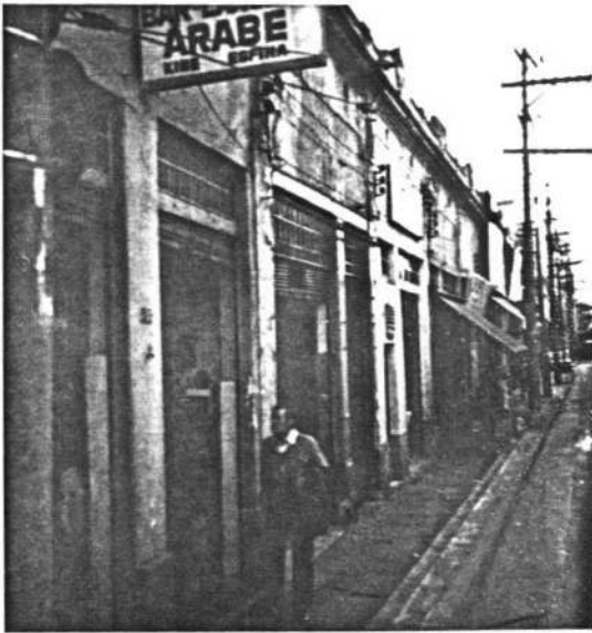
Parte Comercial - Rua São Caetano
