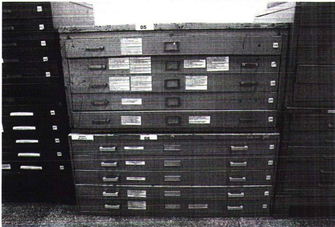
Mapotecas 05 e 06 (numeração do APESP) com arranhões, marcas de ferrugem, desencaixe das gavetas e ausência de puxadores nas mesmas.
