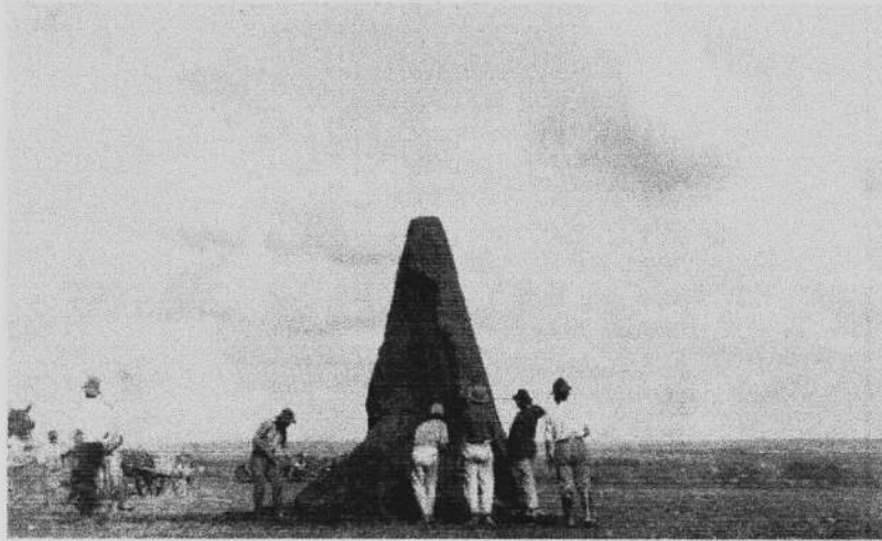
Terra retirada em terraplanagem manual (1927) Arquivo Museu Histórico FMUSP
