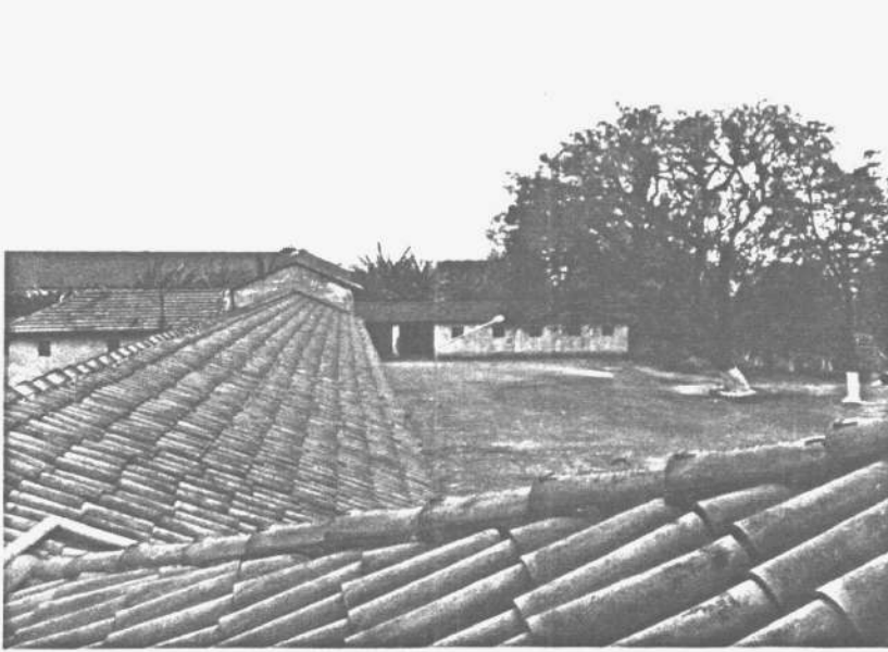
TERREIRO VISTO DO SOBRADO
