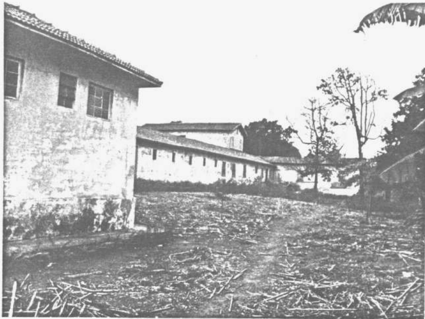
FACHADA POSTERIOR DA CASA E PÁTIO DE SERVIÇO
