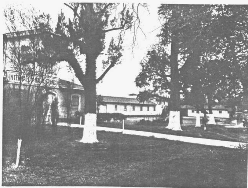
VISTA PARCIAL DA FACHADA, VENDO-SE, À DIREITA, O TERRENO
