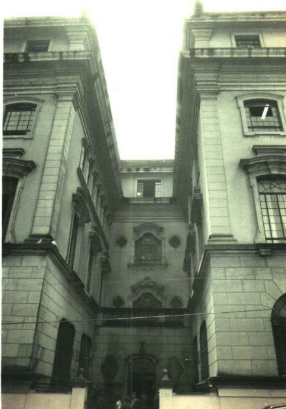
entrada dos fundos.
