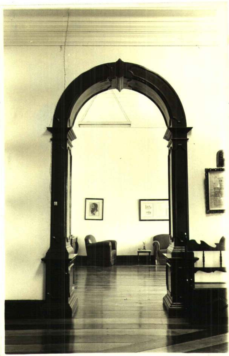
Detalhe do batente no Hall da capela
