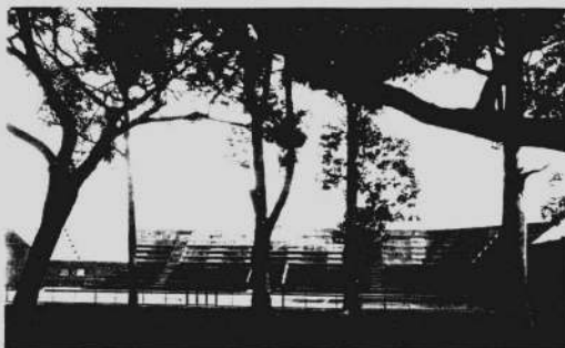
Acima, o estádio Anésio Lara Campos, com arquibancadas construídas em cimento armado, uma novidade tecnológica
