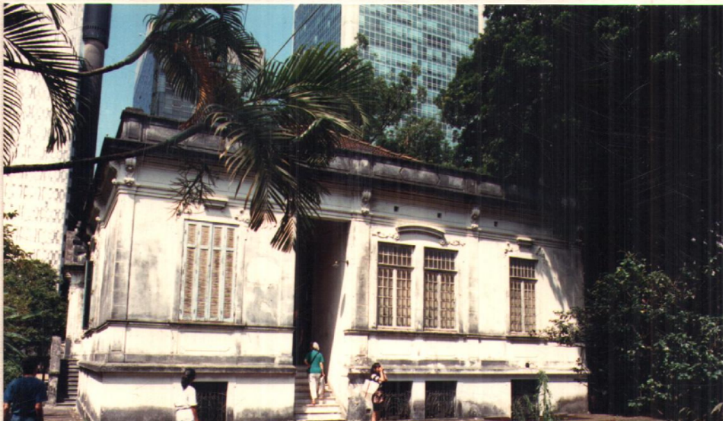
Foto 2 : Parte traseira da residência.
