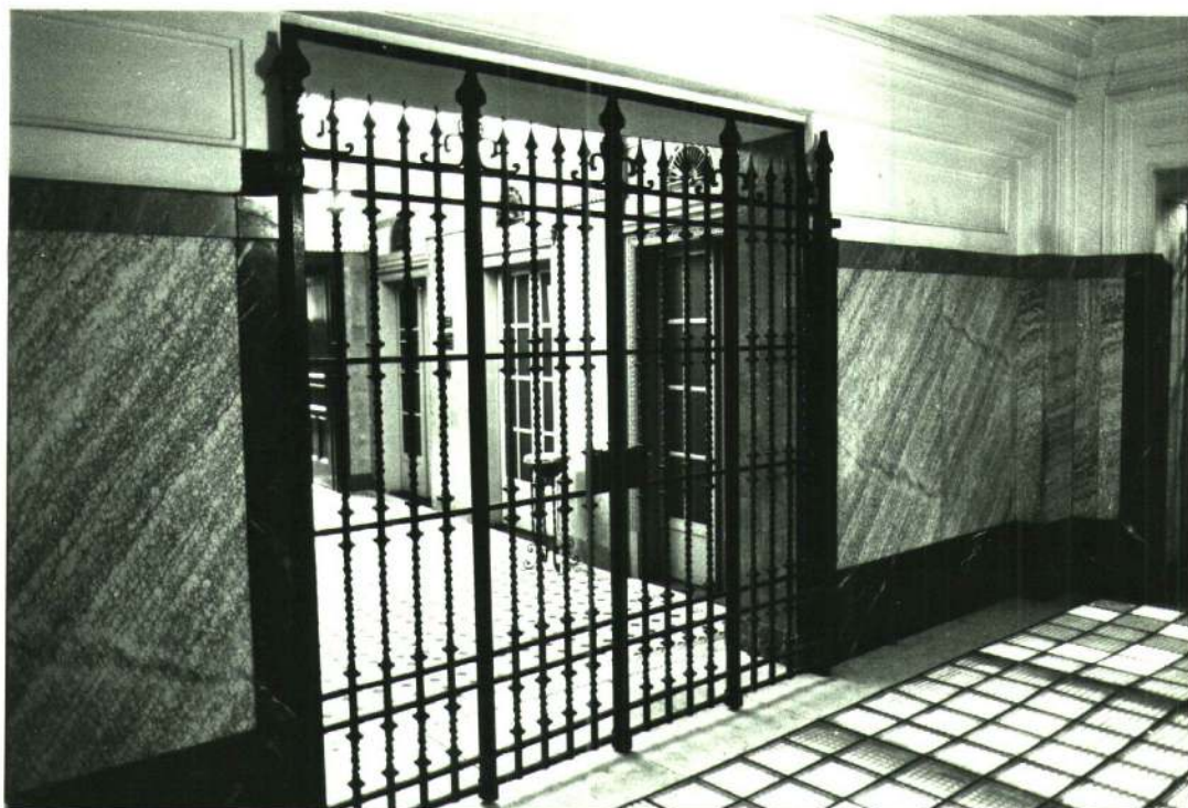
Portão de acesso ao saguão dos elevadores.
