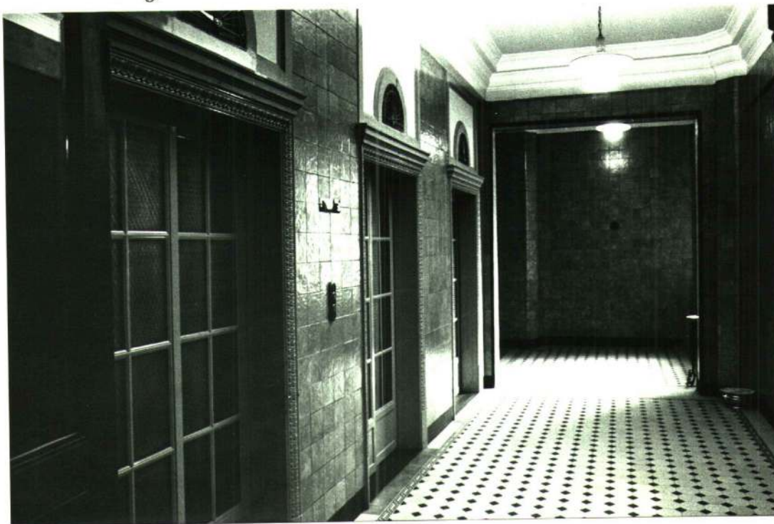
Laguão de elevadores - posterior
