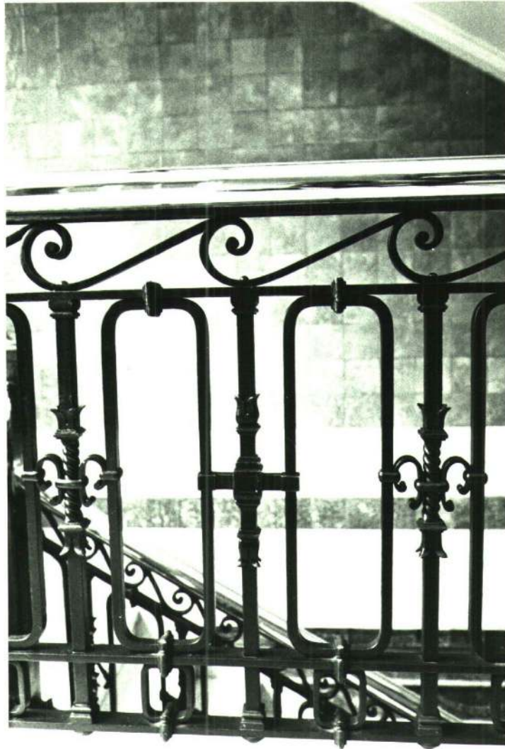
Guarda-corpo de escada
