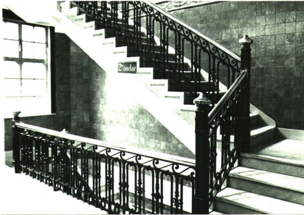
Caixa de escada
