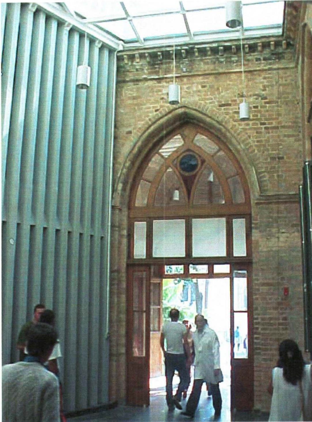
Vista interna da interligação entre a Unidade de Diagnóstico por Imagem e Pronto Socorro Central
