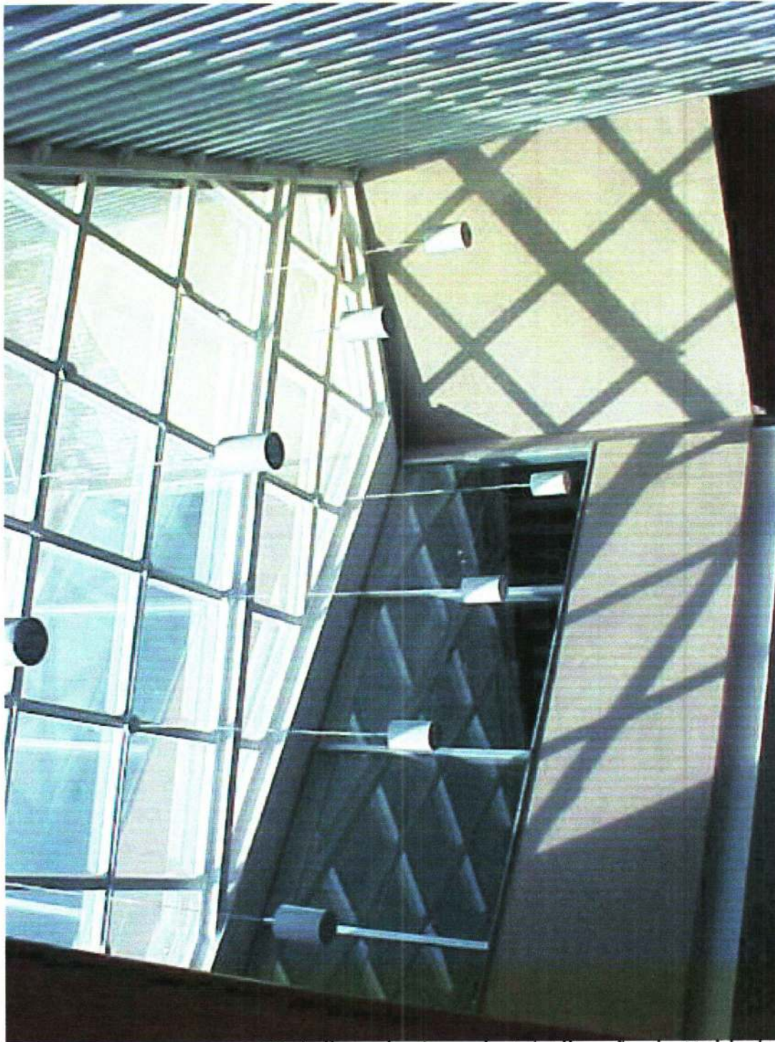
Detalhe cobertura da Interligação da Unidade de Diagnóstico por Imagem e Pronto Socorro Central
