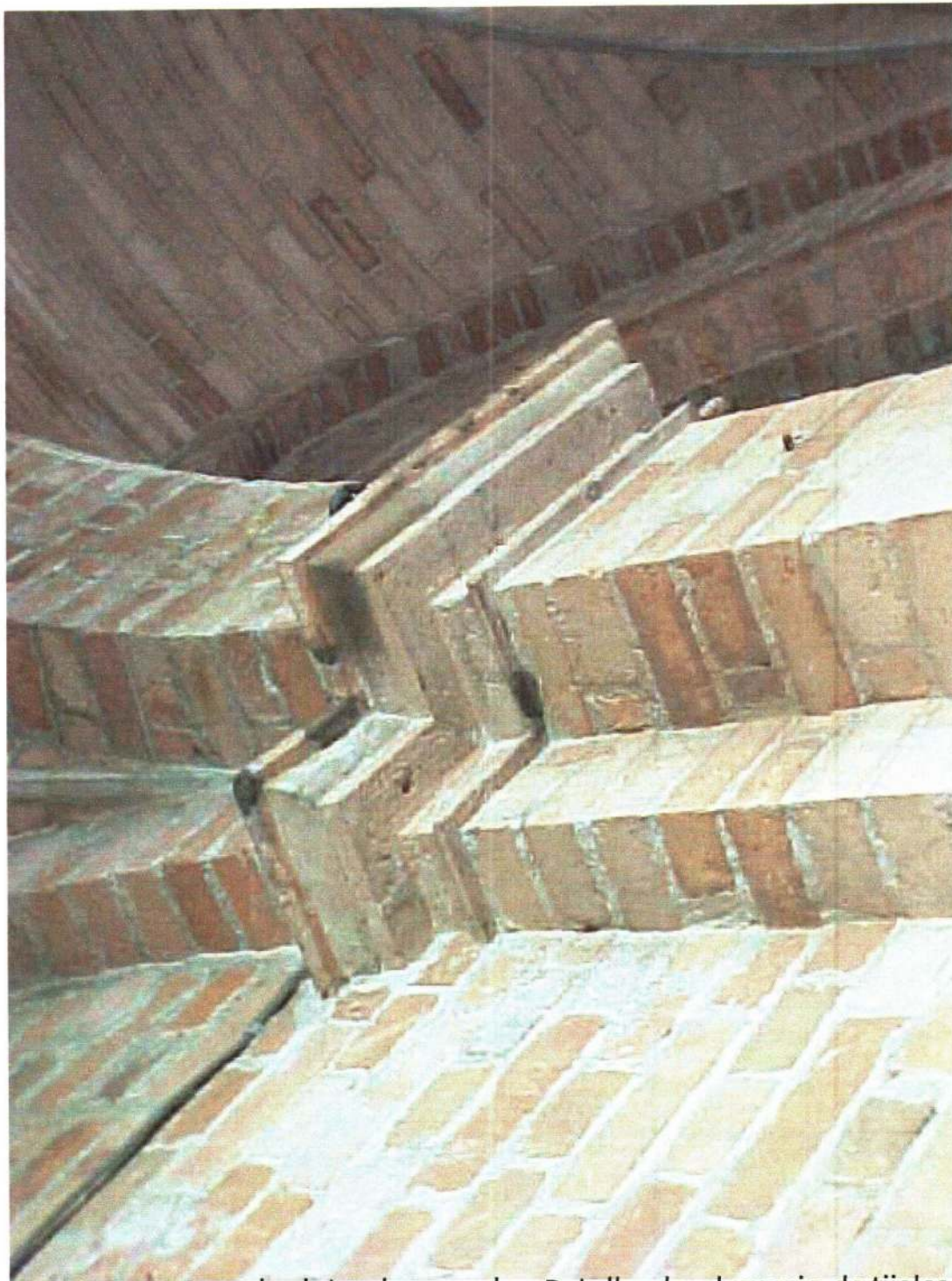
Corredor lateral esquerdo - Detalhe da alvenaria de tijolos
