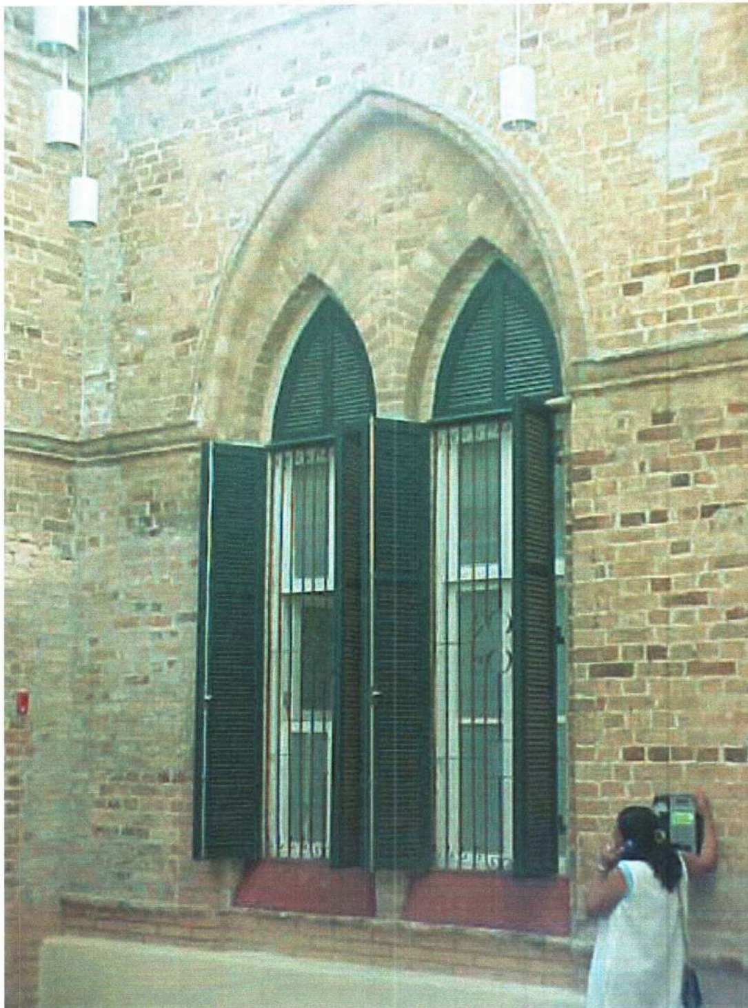
Interligação entre a Unidade de Diagnóstico por Imagem e Pronto Socorro Central - Detalhe do caixilho original preservado e recuperado na reforma do Pronto Socorro Central
