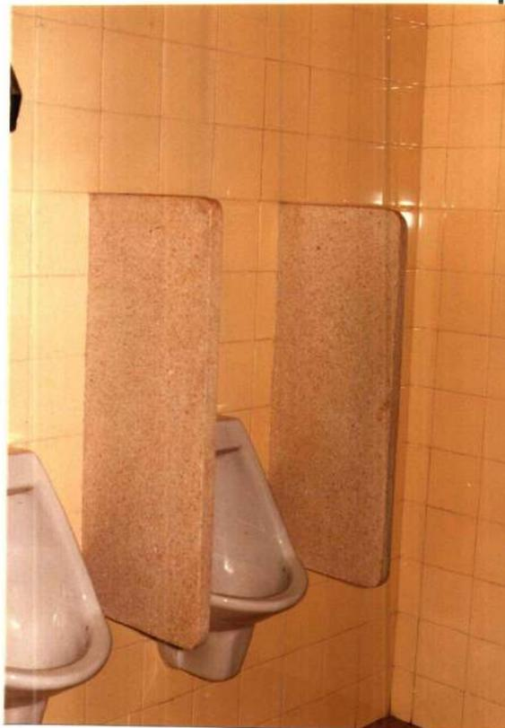
FOTO 5 e 6 - Detalhe mostrando troca de peças, azulejos e piso nos sanitários.
