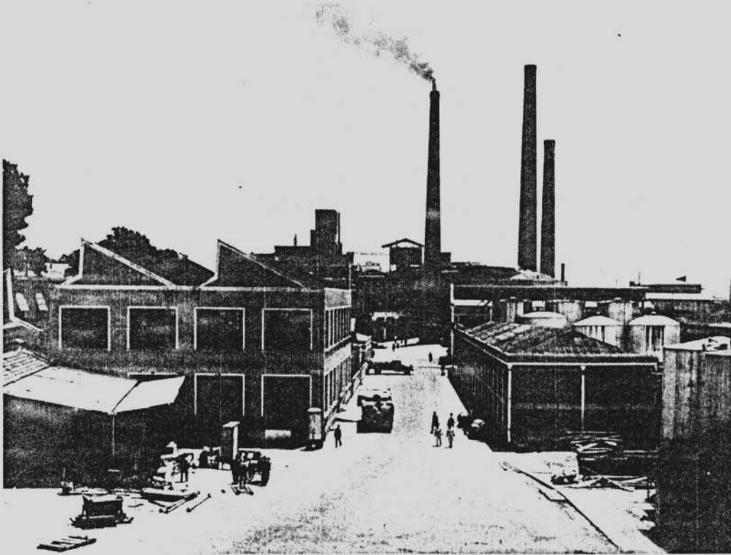
Vista interna do conjunto da Água Branca.
