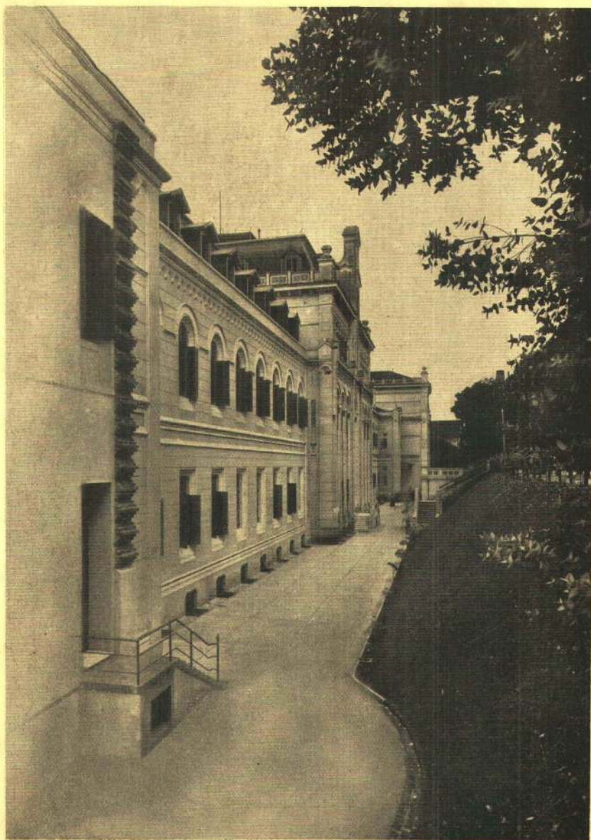
Fachada geral (Rua Maranhão).
