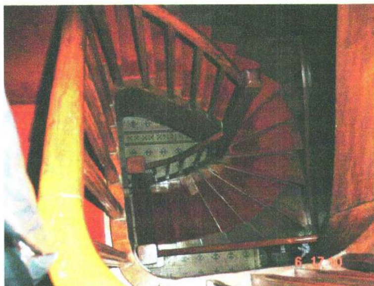
Figura 97 – Escadaria de acesso ao terceiro e quarto pavimentos (fonte: autor)
