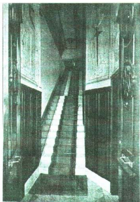
Figura 66 – Escadaria de acesso ao segundo pavimento com os painéis em baixo relevo (Fonte: O PENSAMENTO 212).
