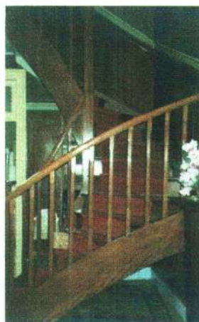
Figura 47 – Escadaria de acesso ao terceiro e quarto pavimentos (Fonte: Autor).
