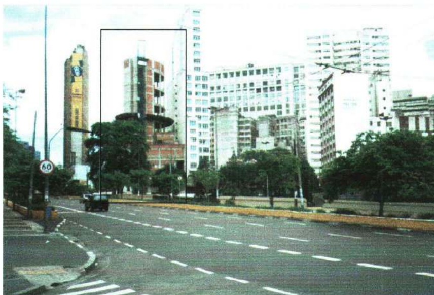
Figura 15 – Edifício O PENSAMENTO em construção na Rua Dr. Rodrigo Silva (Fonte: Foto do autor).
