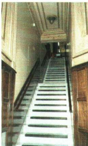
Figura 40 – Escadaria de acesso ao segundo pavimento (Fonte: Autor).
