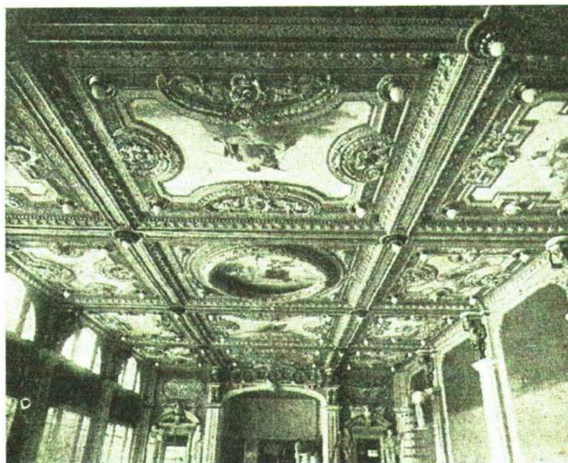
Figura 14 – Vista interna do forro do Salão Nobre do novo Edifício projetado para instalar a Sede e a policlínica do Círculo Esotérico da Comunhão do Pensamento na esquina da Rua Conselheiro Furtado com o Largo São Paulo (Praça Almeida Júnior) (Fonte: O PENSAMENTO 421).
