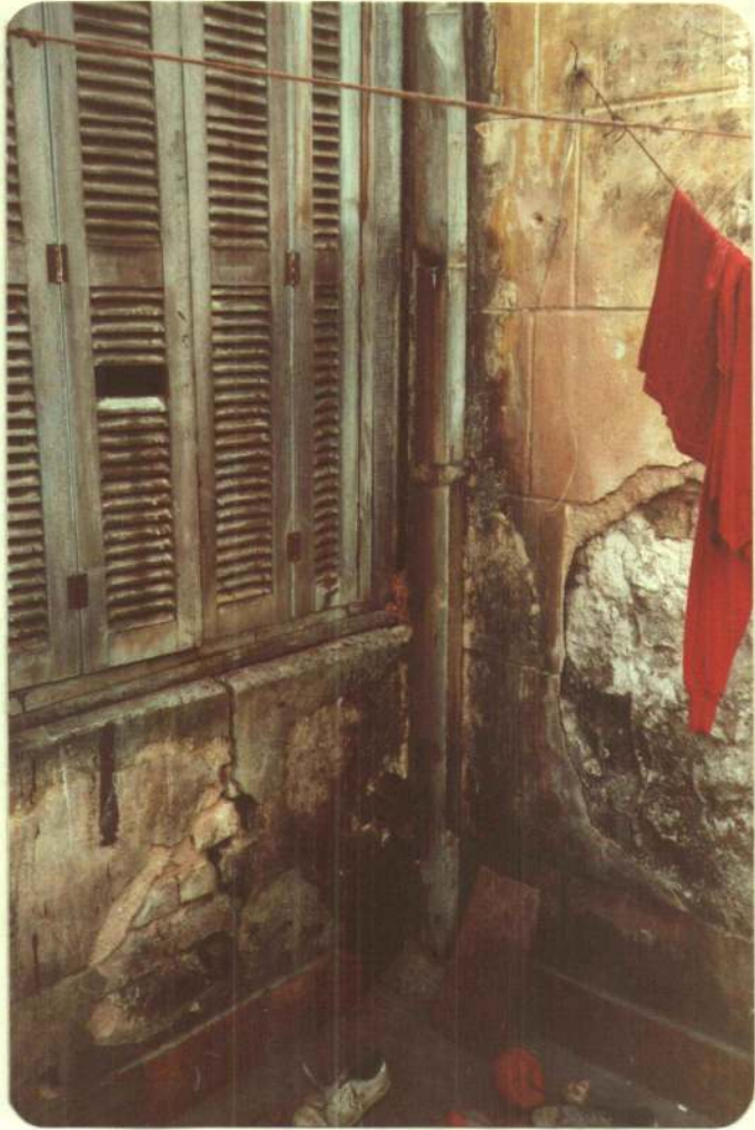
ESTADO GERAL DAS ESQUADRIAS, CONDUTORES E REVESTIMENTO
