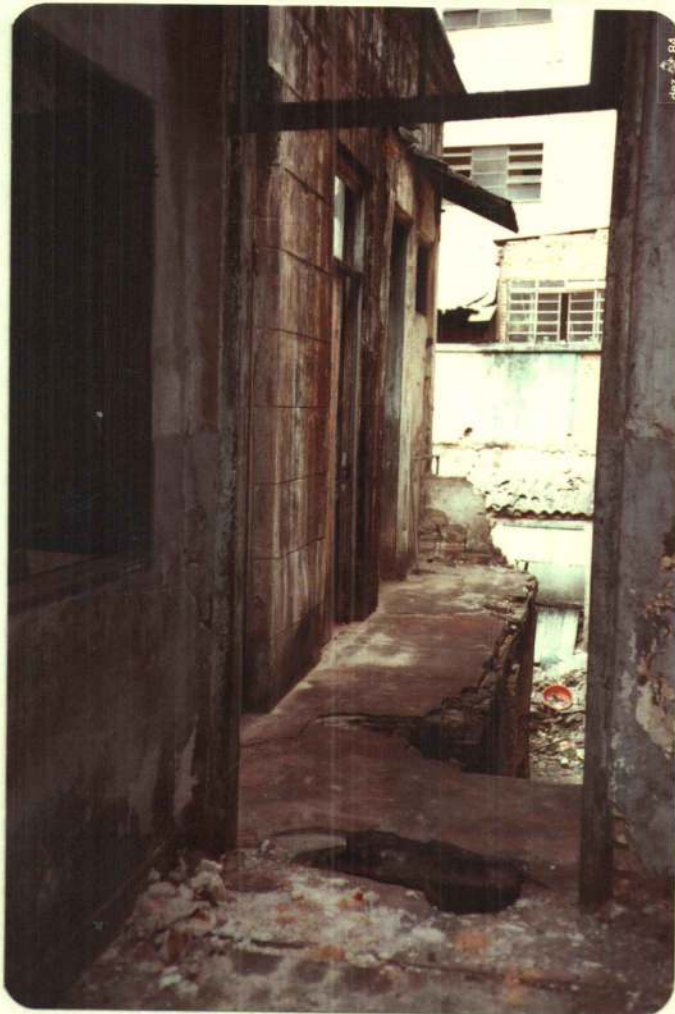
ESTADO GERAL DAS ESQUADRIAS, CONDUTORES E REVESTIMENTO
