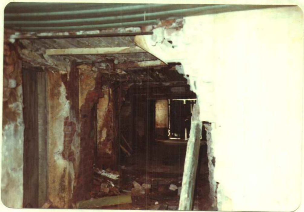
VISTA DO SUB-SOLO
