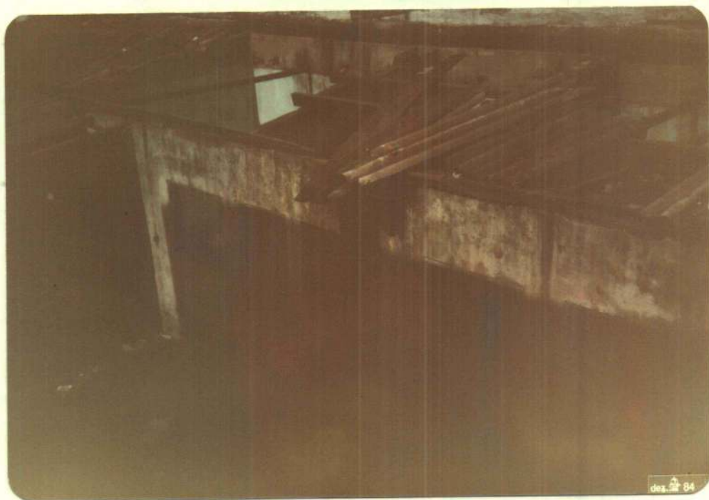
COBERTURA DA EDÍCULA
