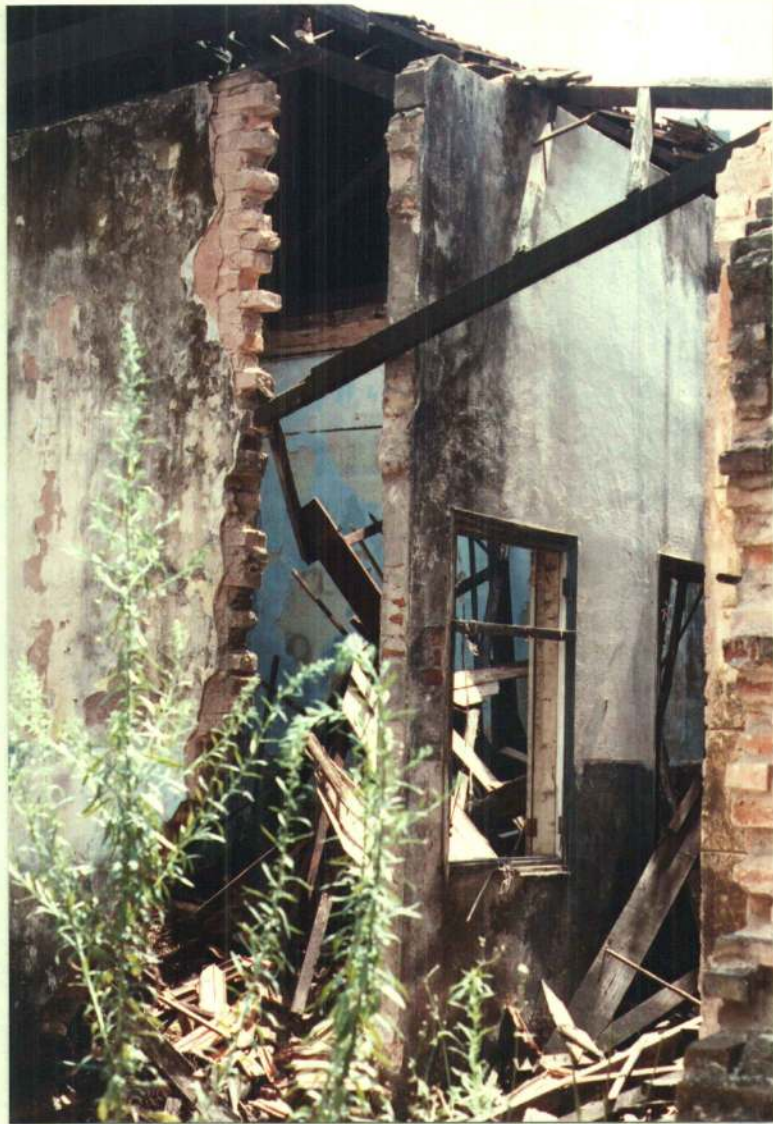
ASPECTO PAREDES, ESQUADRIAS E COPERTURA DAS CASAS.
