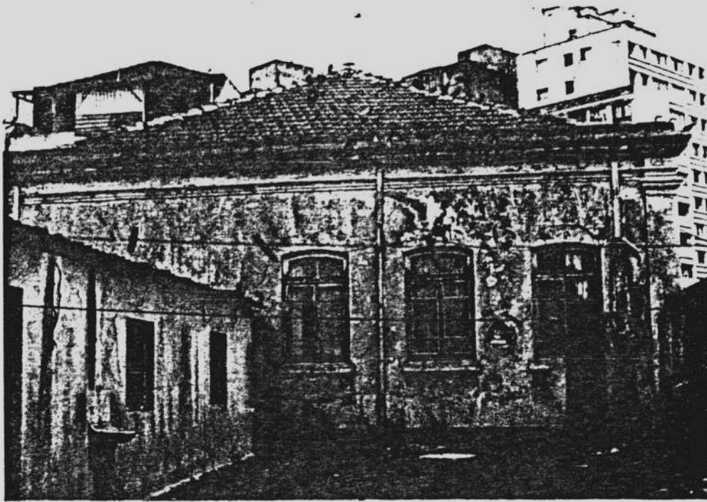
FACHADA LATERAL DIREITA; ORIGINALMENTE NÃO HAVIA ACESSO POR ESTA LATERAL (VER PLANTA)
