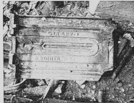
Telha tipo francesa (não original)
