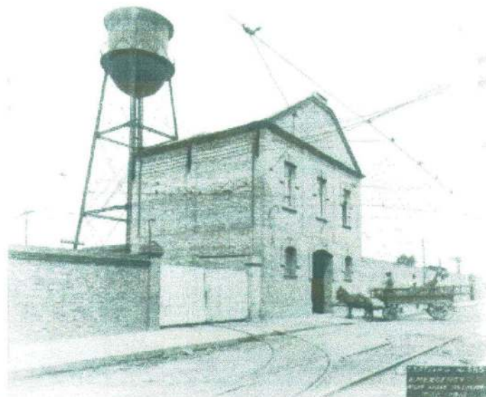
10 – A unidade de emergência, na Rua José de Alencar, em jul. 1916. Foto Guilherme Gaensly. Acervo FPHESP.
