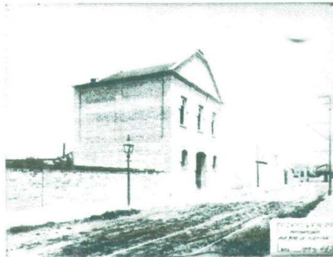
9 – O primeiro edifício construído no terreno da nova Estação de Bondes da Light, no Brás, em 1912. Situa-se na Rua José de Alencar e abrigava a unidade de emergência. Ao fundo a Rua João Alves de Lima. Foto Guilherme Gaensly. Acervo FPHESP.
