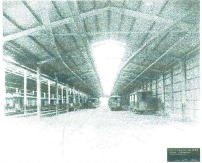
20 - Estação de bondes do Brás, interior, lateral direita, Jan. 1930, Vê-se em detalhe a estrutura do edifício. Foto de Guilherme Gaensly. Acervo FPHESP.
