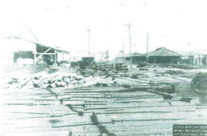
22 – Pátio da Estação de Bondes do Brás, onde era guardado o material do Departamento de Vias. Jun. 1921. Foto de Guilherme Gaensly. Acervo FPHESP.
