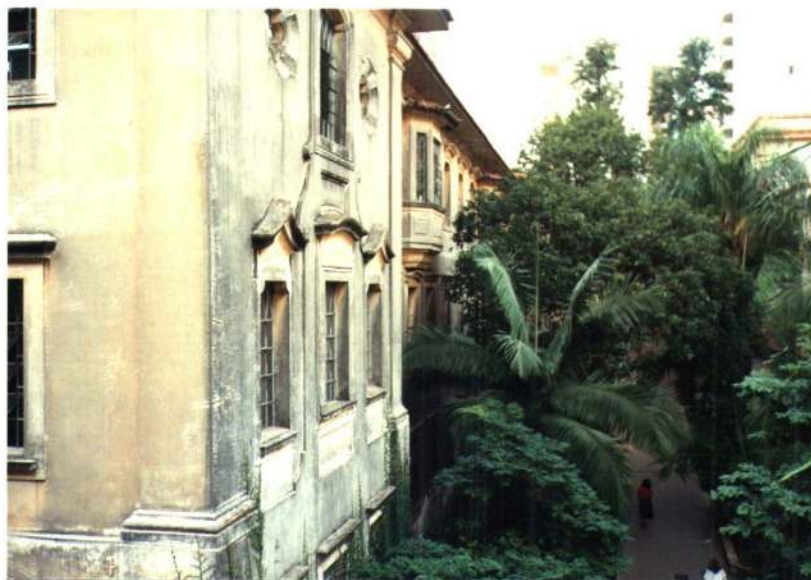
VISTA DOS FUNDOS PRÉDIO-SEDE
