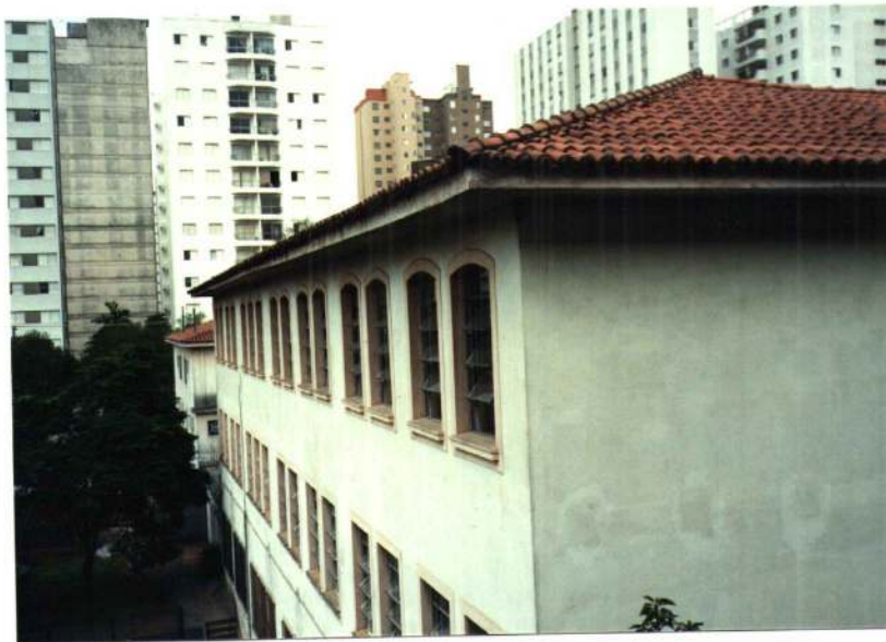
VISTA LATERAL (FUNDOS) PRÉDIO-SEDE
