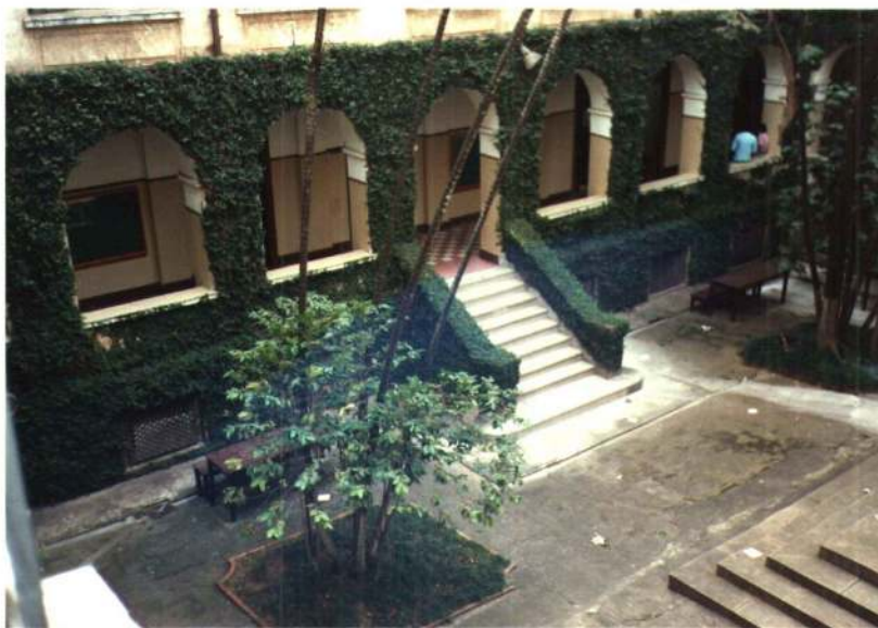
VISTA DO PATIO DA CRUZ A PARTIR DO 1º ANDAR DO PRÉDIO-SEDE
