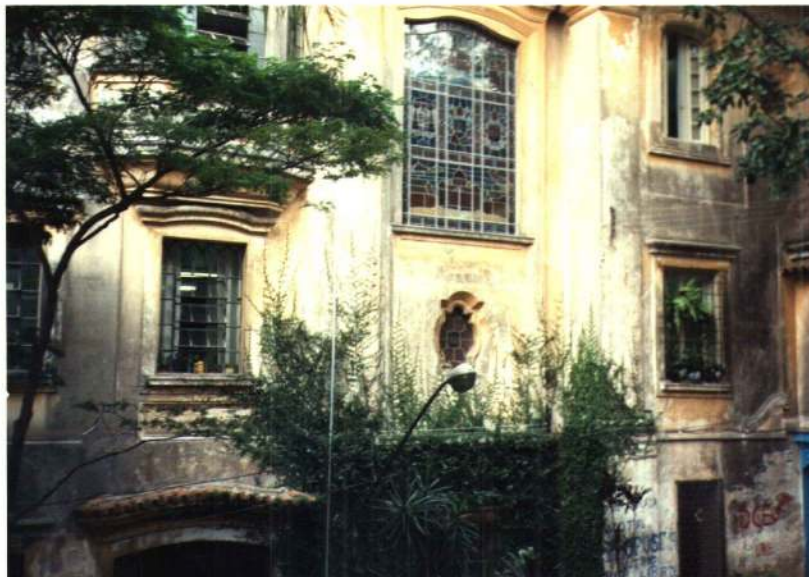
LATERAL DO PRÉDIO-SEDE (VITRAIS FOTO 09 E 10)
