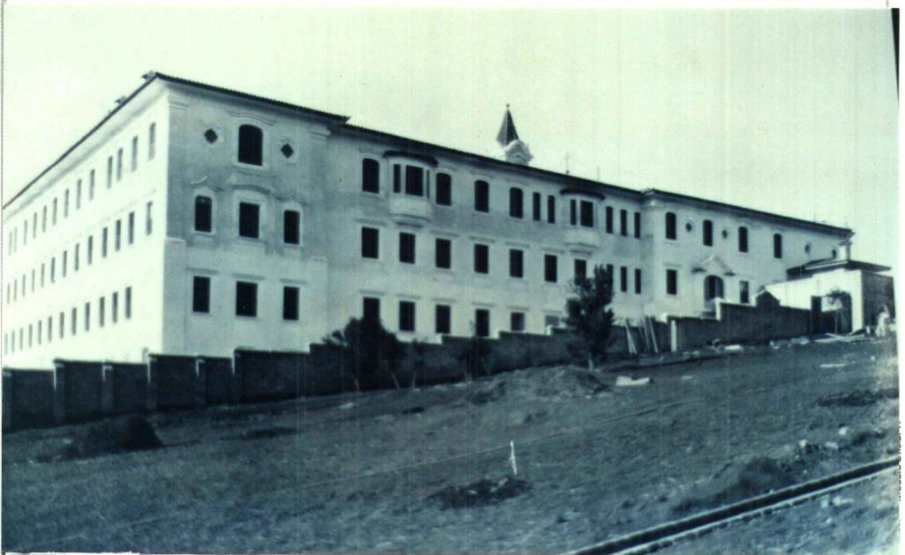
Foto I - Foto da lateral esquerda de quem olha o edifício do antigo Mosteiro das Carmelitas, Perdizes. A comparação com o desenho anterior revela pequenas alterações na composição da fachada em relação aos enquadramentos das envasaduras, visivelmente simplificados na execução. Da construção que se vê à direita, já demolida, não foi possível obter informações; possivelmente servisse de portaria ou de zeladoria. No mesmo ponto havia uma passagem ligando o terreno do Mosteiro e contíguo; neste, possivelmente, houvesse horta ou pomar e hoje está erguido o Tuca. Ver também foto III e, para situação atual, fotos 16, 17 e 18 no caderno apenso a este processo. Arquivo da Cúria, album n.14. Foto c. 1923. Reprodução: Walter Fragoni.
