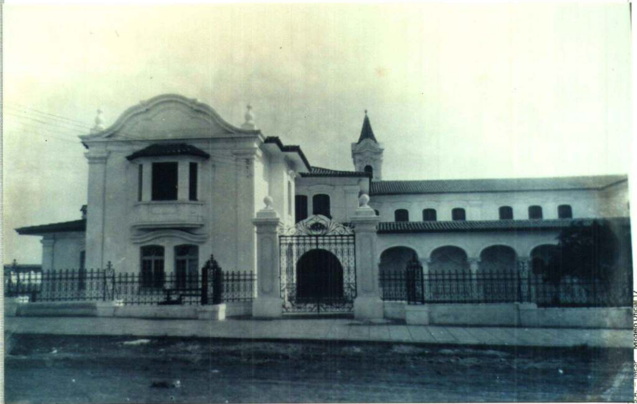
Foto E - Fachada principal, Rua Monte Alegre, Mosteiro das Carmelitas. Nesta foto vê-se o torreão que não aparece na representação gráfica da fachada. Ele é visível também nas fotos de conjunto, xerox I, II e III, provavelmente tiradas logo após a inauguração do Mosteiro. Ver situação atual nas fotos 5 e 6, todas no caderno apenso a este processo. Observam-se pequenas alterações na fachada. Arquivo da Cúria, album n.14. Foto c. 1923. Reprodução: Walter Fragoni.
