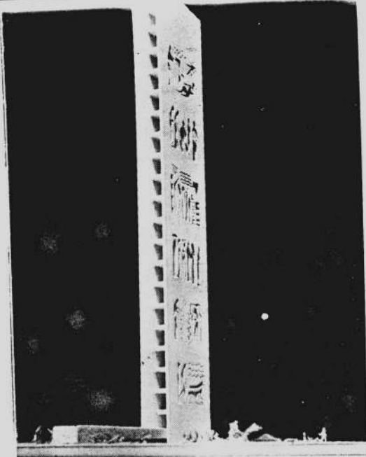
1953 — Projeto de torre da Cidade Universitária, de concreto armado nú, com esculturas em baixo-relievo de Elisabeth Nobile, obtidas com as próprias formas de madeira. A torre compreende 2 paredes de 10 m de largura por 50 m de altura e um sistema duplo de escadas previsto entre as mesmas.
