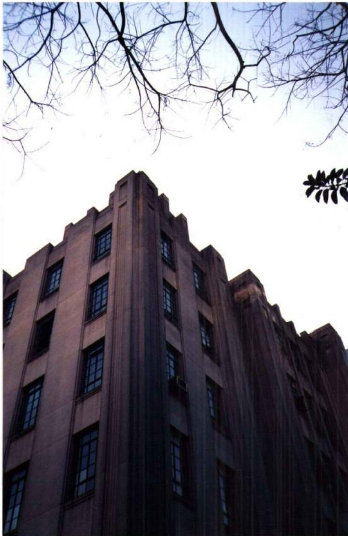
DETALHE DO EDIFÍCIO PRINCIPAL (FACE POSTERIOR / LATERAL ESQ.)
