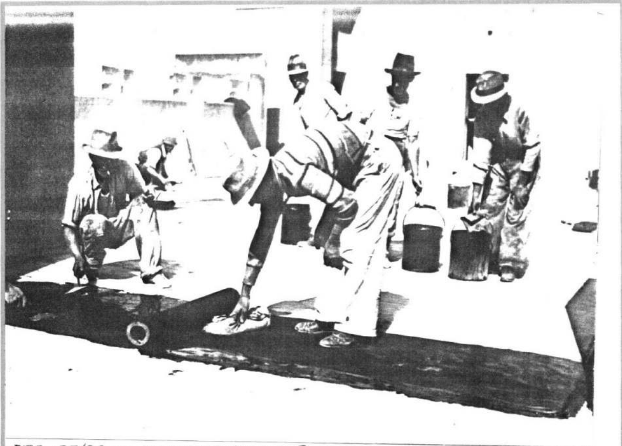
FGS. 25/26 - IMPERMEABILIZAÇÃO DA COBERTURA
