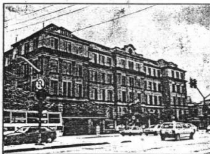
Arquiocesano, fundado em 1935: prédio ocupa quarteirão
