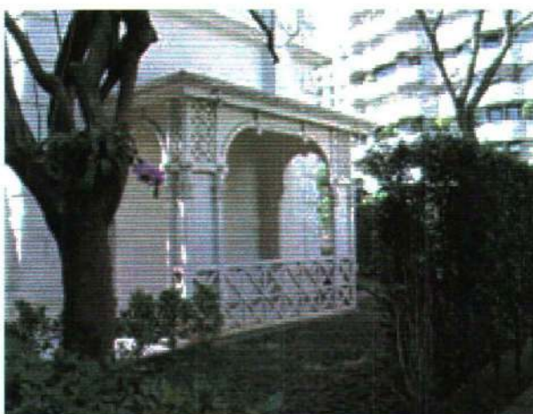
Foto 1 - Reprodução de foto de uma pequena varanda de madeira que se situava na fachada lateral Foto 2 - Terraço Antigo Foto: Edna H. M. Kamide - 5/8/2003
