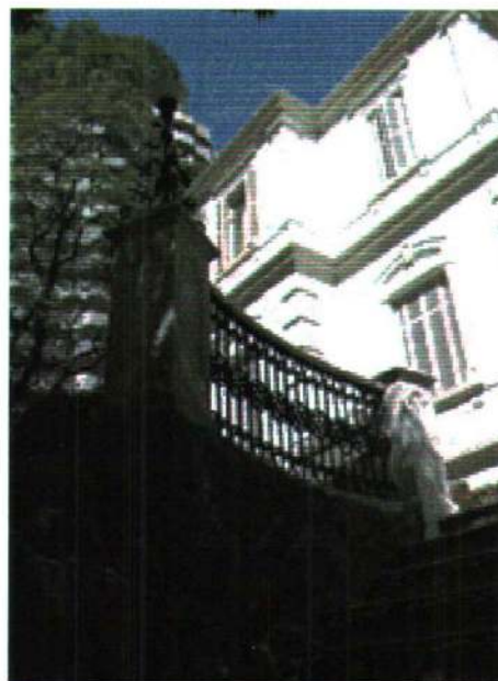
Entrada lateral direita - Escada
