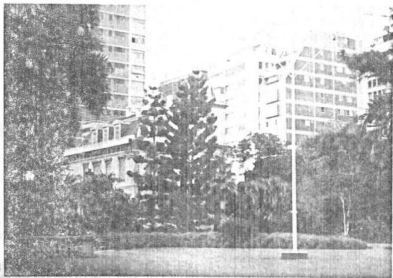
Foto 75 — Aspecto atual da casa de D. Veridiana da Silva Prado. Foto da autora.
