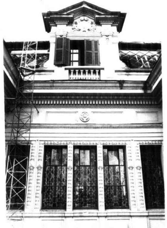
DETALHE DA FACHADA POSTERIOR DA SECRETARIA DE SEGURANÇA
