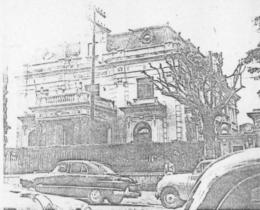
Av. Higienópolis 1952-4 Força Pública do Estado de São Paulo Foto: Agência Estado
