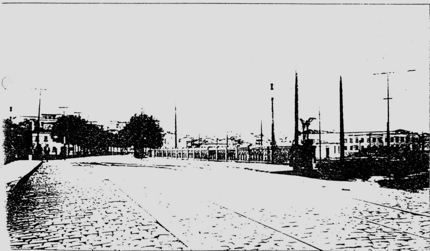
Sobre o rio Tamanduateí rumo à Mooca. Observem-se os Lâmpêes de Gás.
