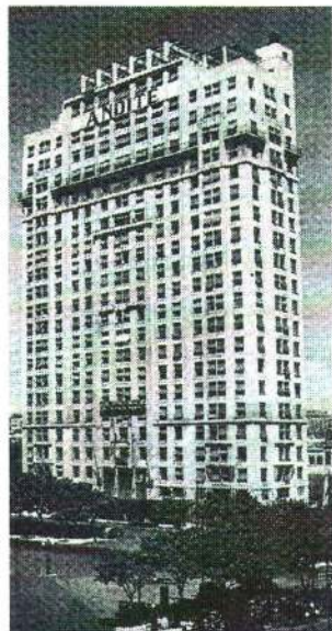
Figura 15. Edifício A noite. Fonte: GATI, 2000.
