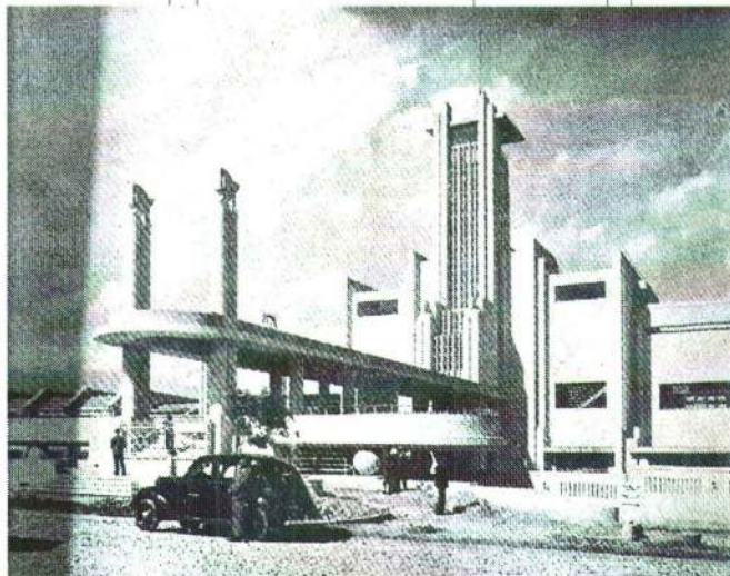
Figura 24. Foto da inauguração, 1941. Fachada da sede social e passadiço de entrada. Nota-se a diferença de desenho do que foi construído para o que foi projetado. Fonte: Arquivo Jockey Clube, década de 1940.
