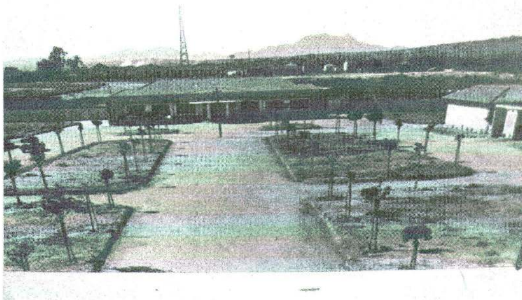
Figura 31. Imagem da Vila Hípica na época da construção do Prado. Nota-se ao fundo o antigo prédio da administração. Fonte: Arquivo Jockey Clube, cerca de 1940.
