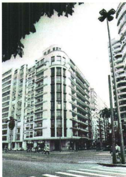
Figura 50. Edifício Tabor Loreto. Fonte: Arquivo da Biblioteca ViverCidades / foto: Eleonora Figueiredo de Souza. In: ALMADA, 2009.
