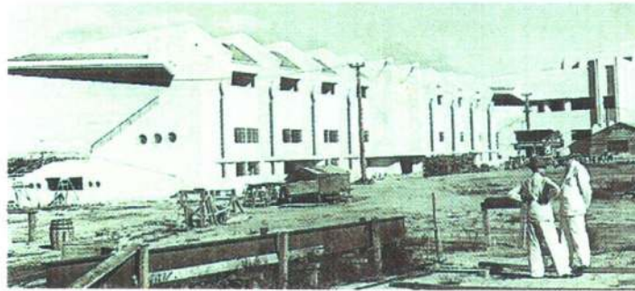
Tribuna para sócios, em construção. (Revista AU, n. 91)
