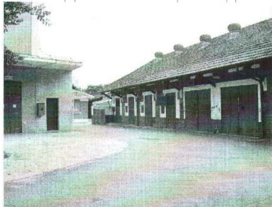
Figura 94. Baías para internação de cavalos doentes, adjacente ao prédio da veterinária. Foto: Priscila Miura, 2009.
