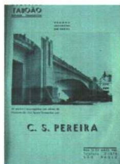
Propaganda C. S. Pereira, fornecedores de pedra britada para construção do Viaduto do Chá. Álbum da Sociedade Comercial e Construtora Ltda.s/d
