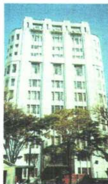
Edifício Saldanha Marinho. Largo São Francisco, São Paulo, 1929
