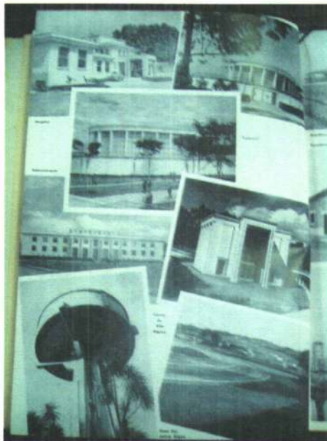
No sentido horário: Hospital; 3 vistas do Tattersal; curva da Vila Hípica; uma das Caixas d' Água; Prédio da Administração.
