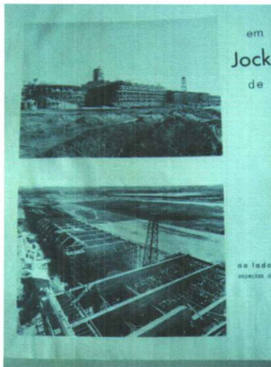
Aspectos da construção da arquibancada. Revista Turfe e Elegância , 1939
