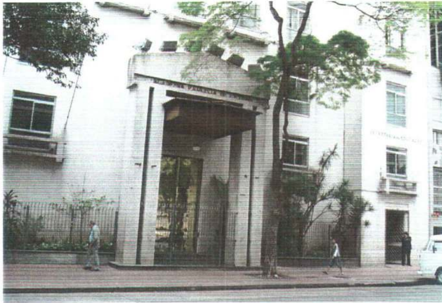
Entrada central - Fachada frontal. data: 08.09.08 foto: Vanessa Kraml
