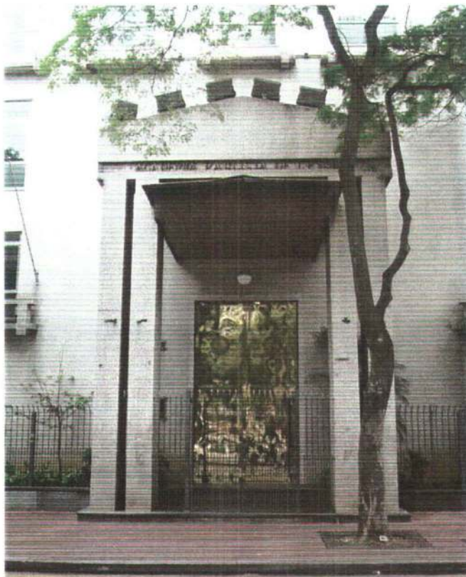
Entrada central - Fachada frontal. data: 08.09.08 foto: Vanessa Kraml
