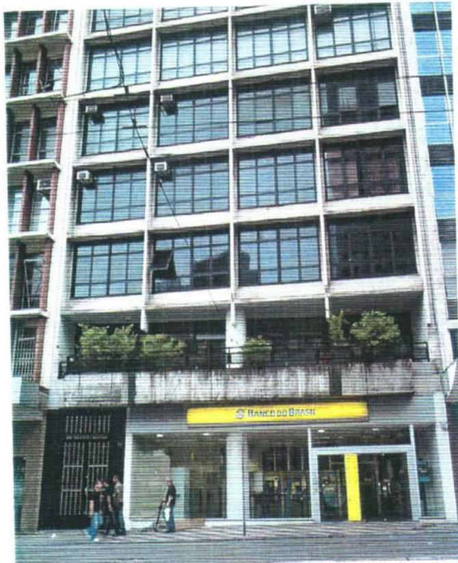
Edifício Vicente Filizola (1950). foto: Cristina Machado data: 06.10.08
