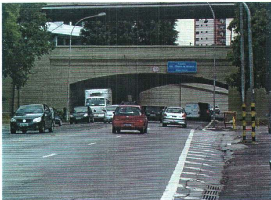
Viaduto da Avenida Pacaembú (1939). foto: Vanessa Kraml data: 06.10.08
