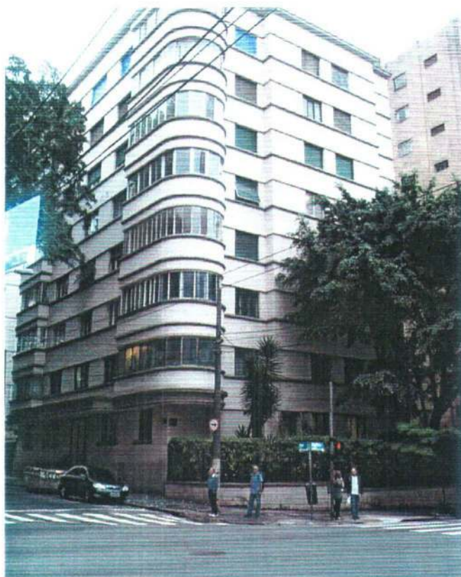
Edifício Santo André (1935). foto: Cristina Machado data: 06.10.08
