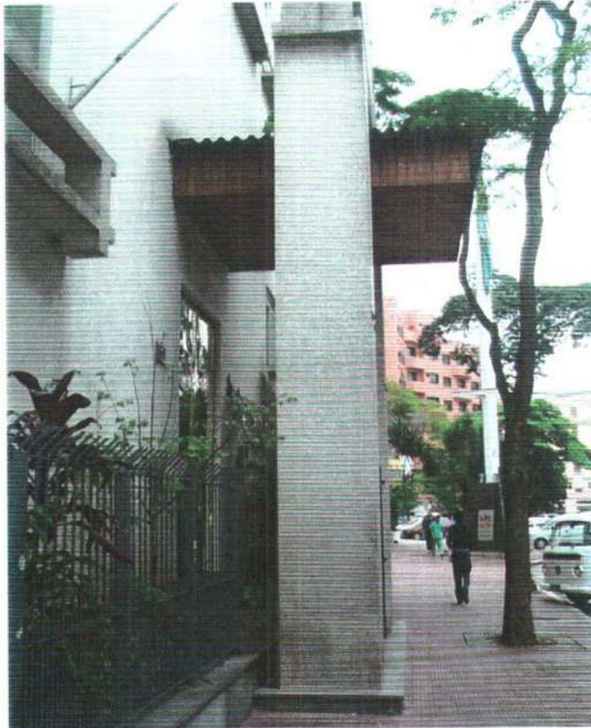
Pórtico - Fachada frontal. data: 08.09.08 foto: Vanessa Kraml
