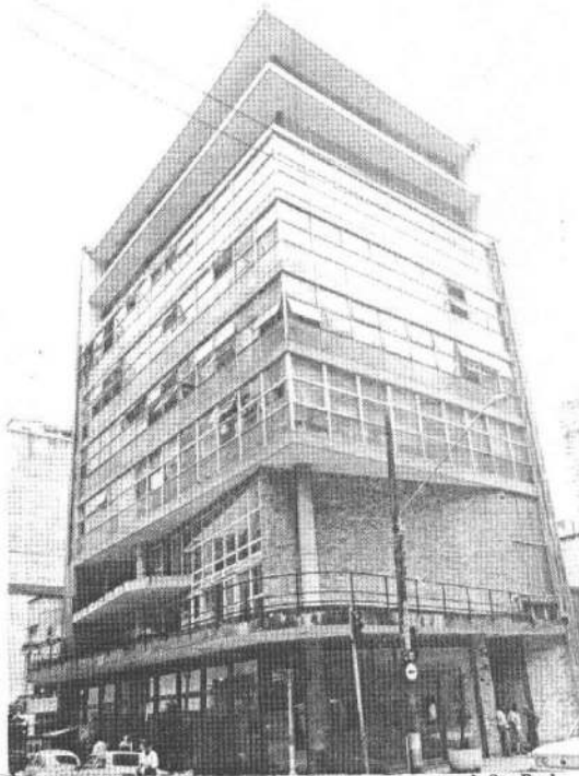
Prédio em reforma do Instituto dos Arquitetos, no centro de São Paulo
