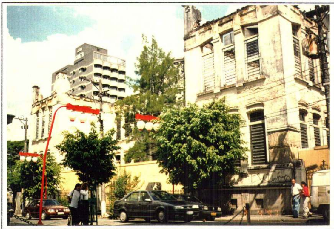
FOTO Nº 01 - VISTA DA FACHADA DO IMÓVEL PELA RUA SÃO JOAQUIM.
