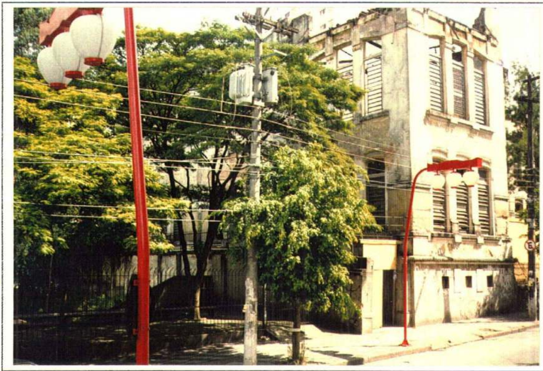
FOTO Nº 02 - VISTA PARCIAL DA FACHADA DO IMÓVEL.
