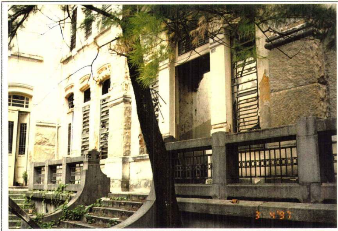
FOTO Nº 03 - DETALHE DE UMA DAS LATERAIS DO IMÓVEL.
