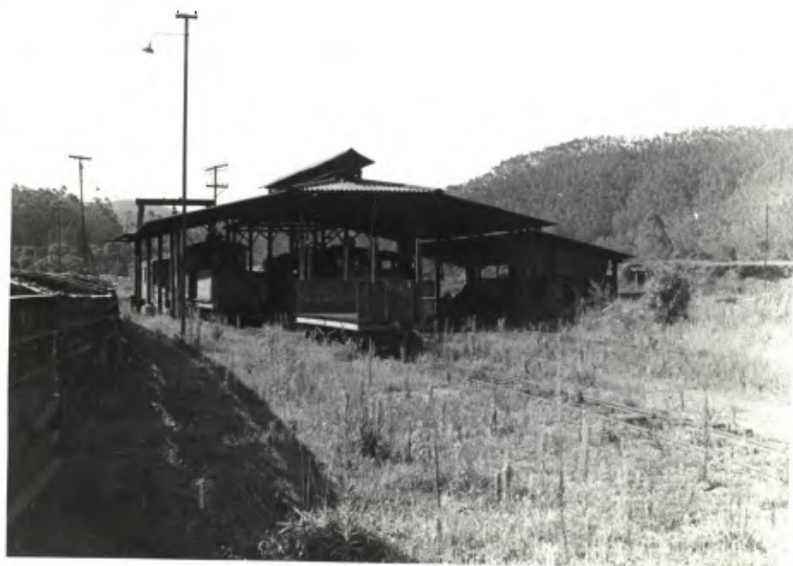
GALPÃO PARA ABRIGO DE LOCOMOTIVAS
