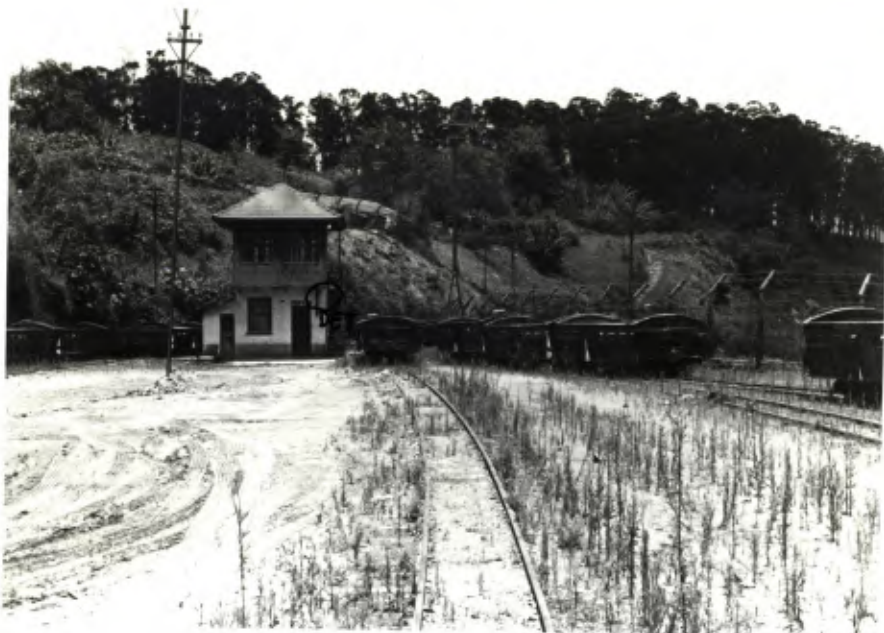
CABINE DE COMANDO (COMPARE COM FOTO Nº 10, FLS. 36)
