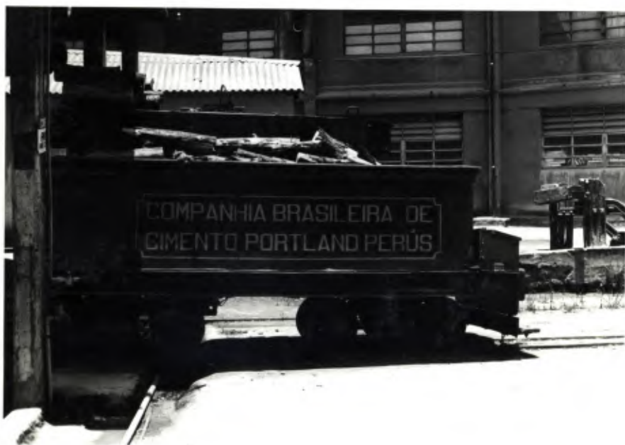
LOCOMOTIVA N° 16 - ABRIGADA SOB UM TELHEIRO NA FÁBRICA DE CIMENTO EM PERUS
