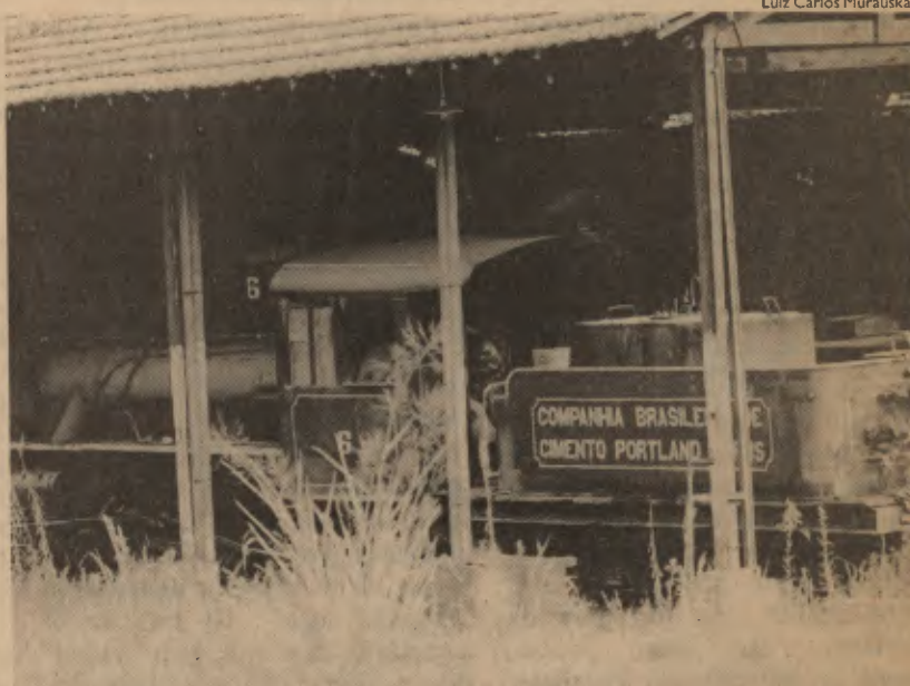
Locomotiva desativada da Perus-Pirapora, encostada em Cajamar
