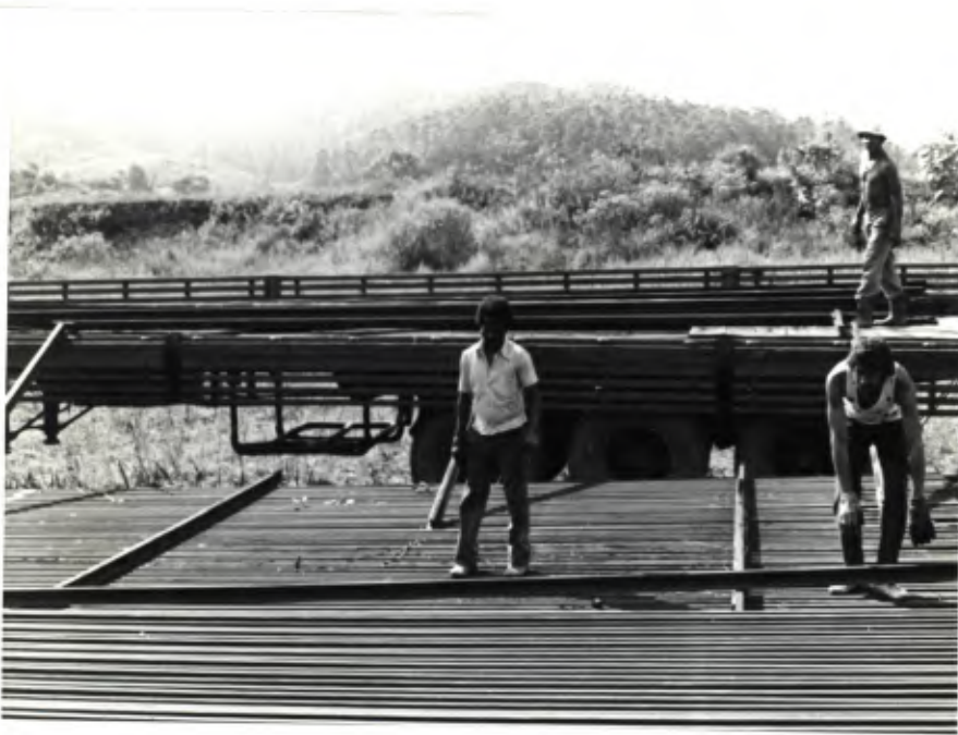
TRILHOS SENDO PREPARADOS PARA TRANS- PORTES
