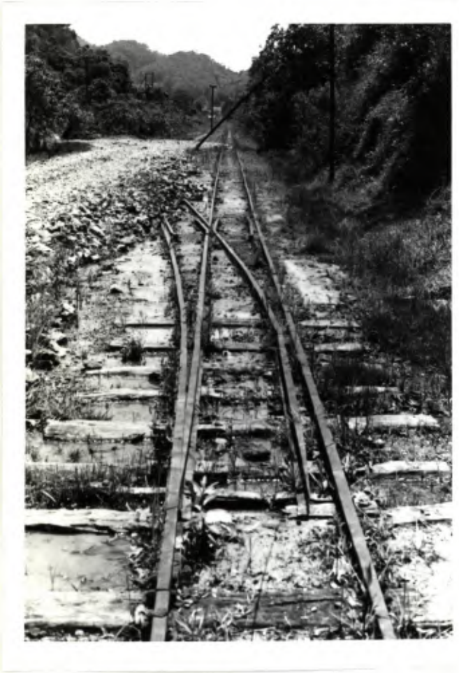
O SISTEMA DE TRANSPORTE DE MATÉRIA - PRIMA ESTA COMPLETO- METIDO, O LEITO FERROVIÁRIO FOI RECOBERTO NESTE PONTO INICIAL COM PEDREBUCHOS
