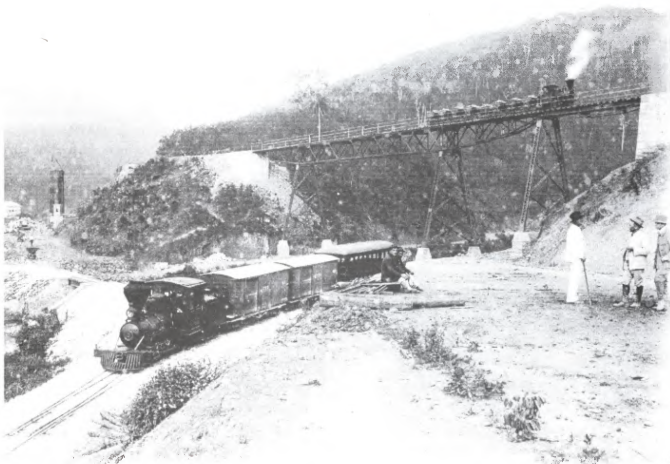
ACIMA - Locomotiva n.º 3 - "Dr. Jambeiro" - Baldwin 2-4-0, no pátio de Gato Preto, em 1914. Observe-se o carro de passageiros aberto, e o viaduto de ligação da pedreira com os fornos. O viaduto foi removido na época da construção da via Anhanguera. (Foto: ABPF/Nilson Rodrigues)
