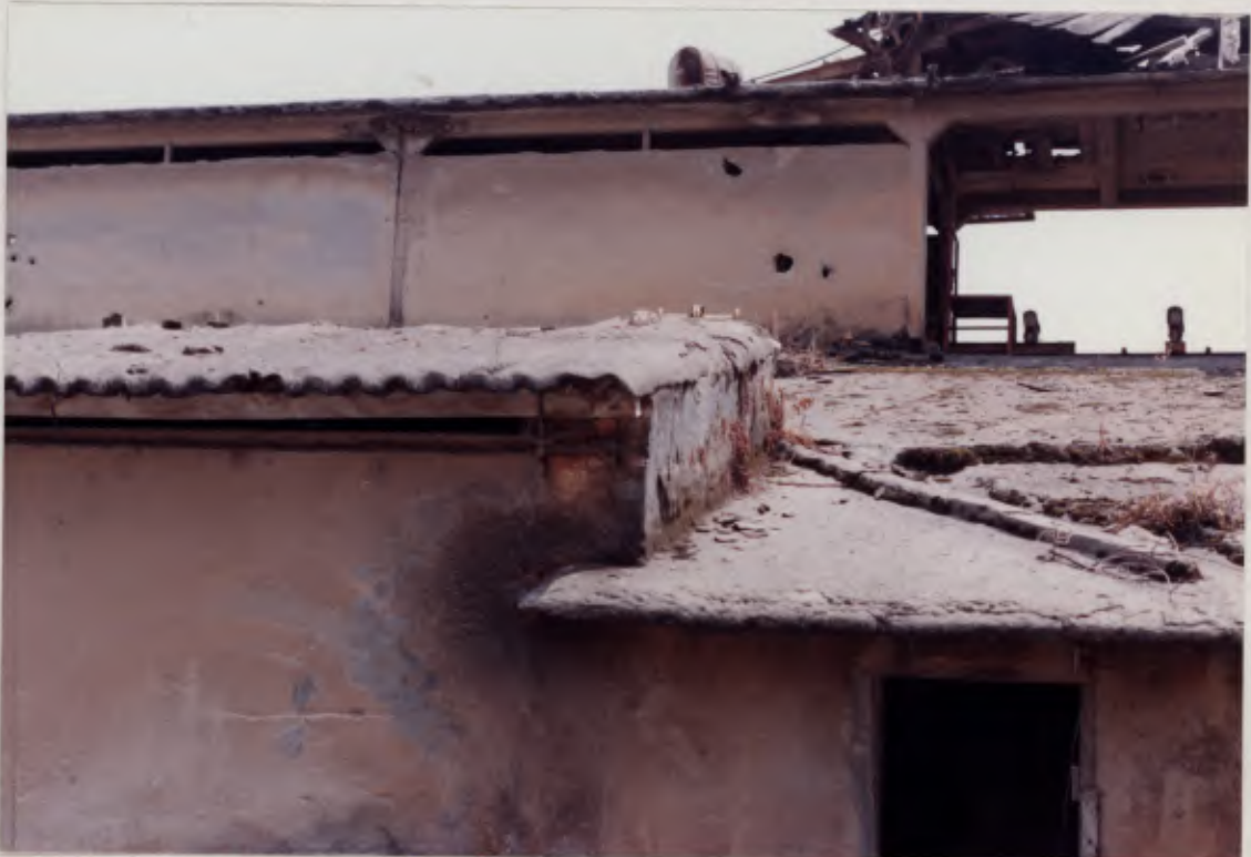
Fotos 24 e 25: detalhes dos edificios dos moinhos
