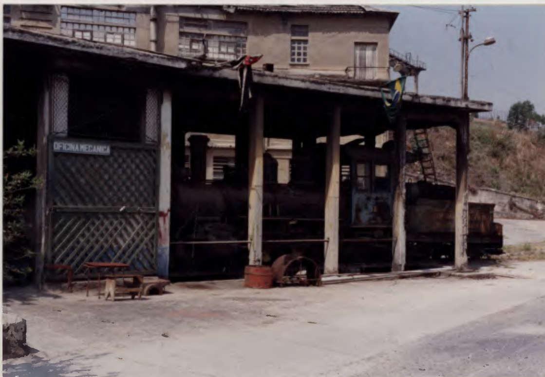
Foto 56: locomotiva nº 16 abrigada parcialmente na Fábrica de Cimento.
