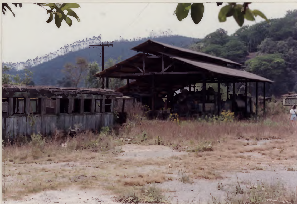
Foto 52: locomotivas abrigadas sob galpão próximo a administração do Pátio de Cajamar. Notar outro carro de passageiros ao relento.
