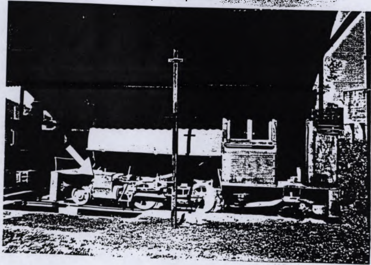
Foto 77. Locomotiva 5 com ambas as placas desaparecidas.
