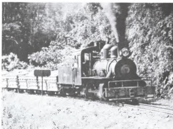
Locomotiva n.º 7 (PORTER 2-6-2) idêntica a n.º 6, adquirida em 1945, e fotografada aqui, saindo de Cajamar, 1974. Segundo consta, foram as últimas de bitola 60cm para o Brasil. (Foto: James Ehernberger)
