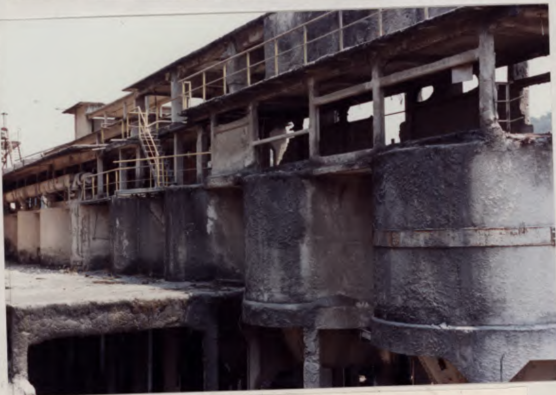
Foto 19: parte superior do depósito de pedras, onde as esteiras jogavam o calcário.
