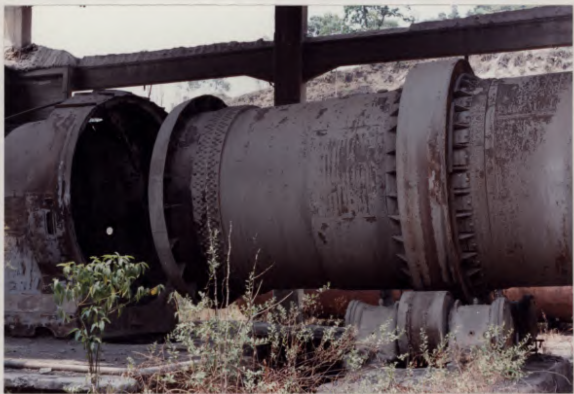
Foto 26 e 27: detalhe do forno para clínquer
