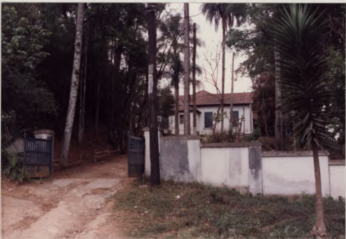
Foto 44: Vista do terminal de Gato Preto onde propõe-se a preservação da estação, caieiras, casa do administrador e oficinas. Foto 45: casa do administrador, proposto nível de preservação P2.
