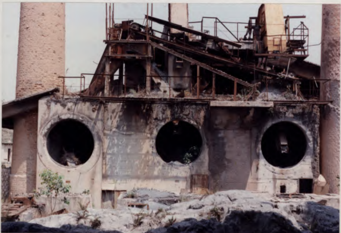
Foto 22: maquinário interno. Foto 23: detalhe do depósito de pedras
