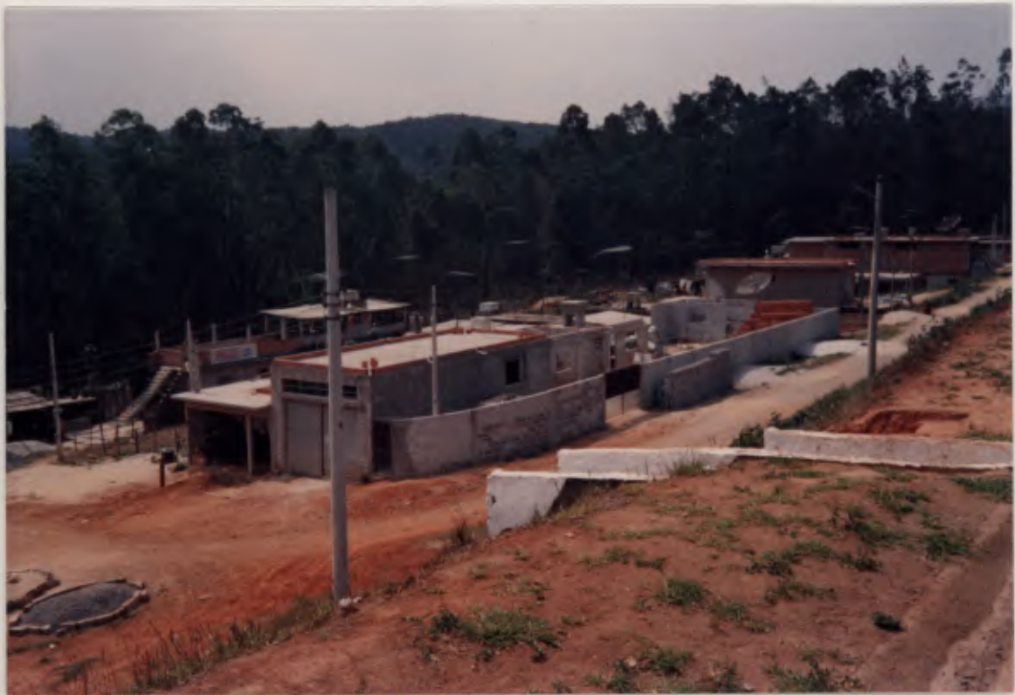
Foto 59 e 60: loteamentos clandestinos em área envoltória da EFPP, muito próximos ao leito da ferrovia. Área do município de Cajamar, ao longo da estrada Polvilho-Cajamar
