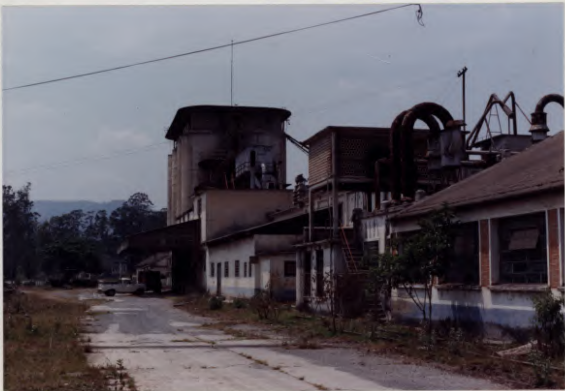
Fotos 5 e 6: prédio principal dos silos e ensacadeira onde encontra-se a marca da empresa. Edificação proposta para tombamento com nível de preservação P2.
