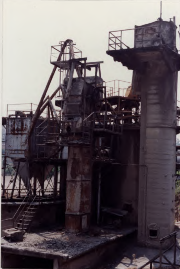
Foto 30: área dos silos
