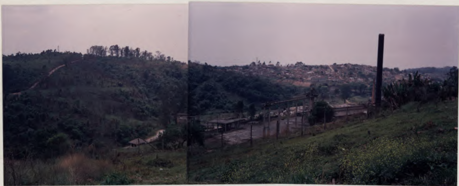
Fotos 37 e 38: vista de cima do conjunto da Fábrica de Cimento.
