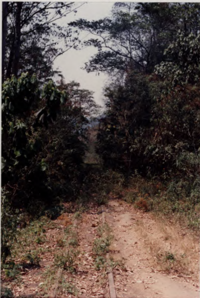
Fotos 3 e 4: trechos da linha férrea no interior do Parque Anhanguera. Notar o crescimento de vegetação em faixa de domínio da ferrovia.
