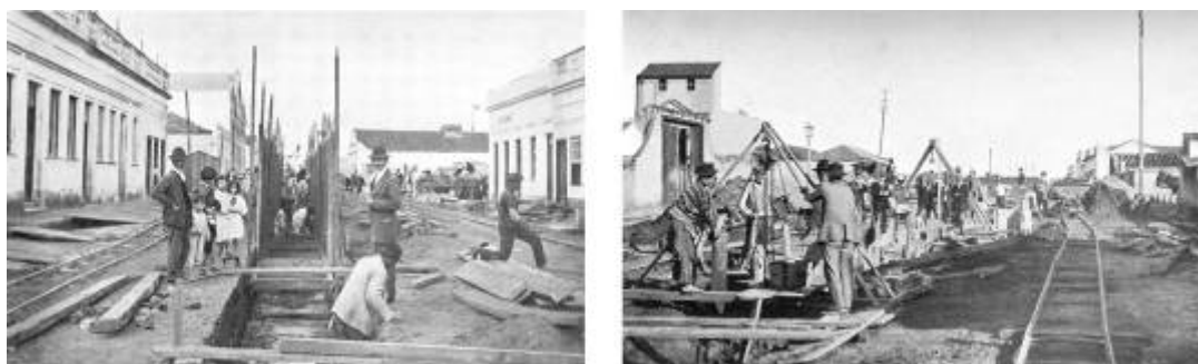
Figura 146: Obras de instalação da rede de esgotos em Pelotas Retirada do escoramento (esquerda) e escoramento (direita).
