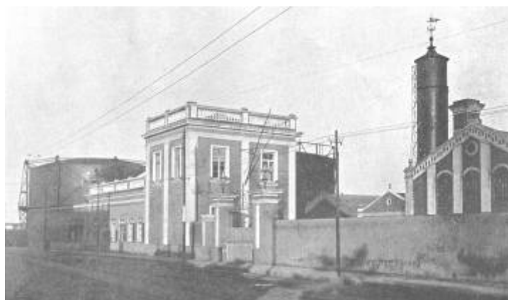
Figura 81: Vista do Gasômetro Municipal instalado às margens do Guaíba. Porto Alegre - RS
