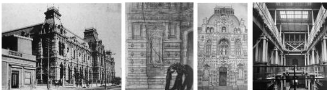
Figura 153: Palácio das Águas, Buenos Aires, Argentina Palácio no início do século (esquerda), desenho retratando a montagem da obra (José Marchi, 1996), aquarela da fachada (Eduardo Audvert, 1995) e estrutura metálica dos tanques (direita). Fonte: GUTIÉRREZ, Ramón. Buenos Aires: obras monumentales . Buenos Aires: Zurbaran Ediciones, 1997, p.46, 49, 56 e 58.
