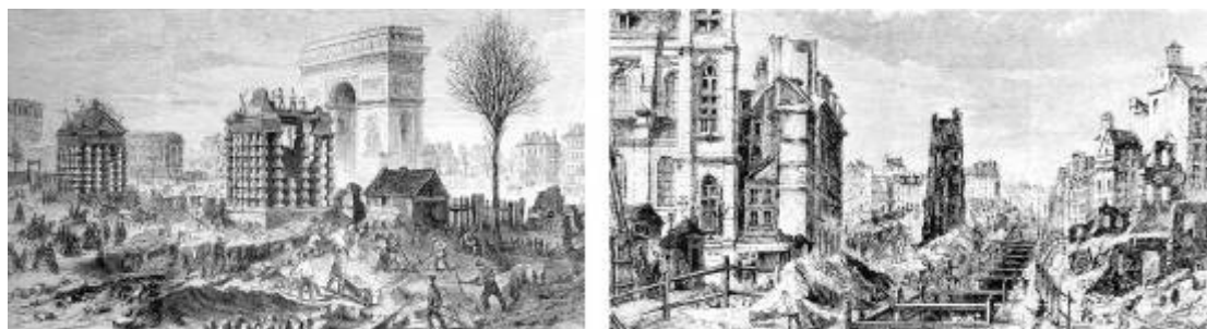
Figura 56: Demolições do tecido antigo
