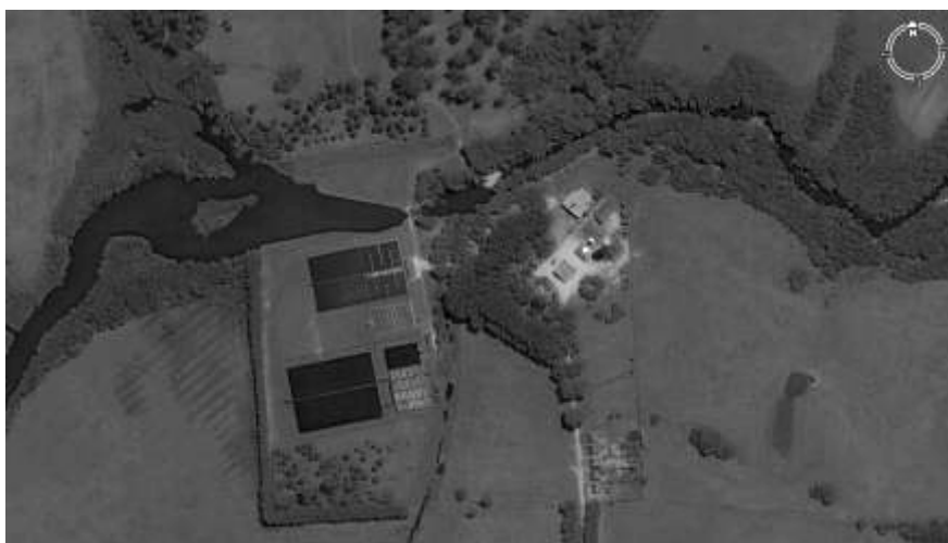
Figura 93: Vista aérea das instalações junto ao arroio Moreira O rio represado (esquerda), os filtros (abaixo), instalações de apoio e leito do rio com mata ciliar (direita). Fonte: Google Earth, Image 2007, Digital Globe.
