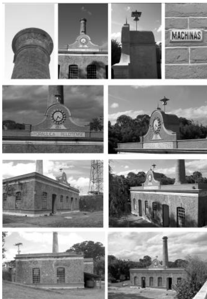
Figura 136: Casa de Máquinas da represa do Moreira Fonte: acervo pessoal, 2006.
