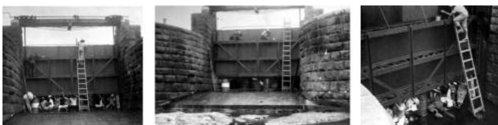
Figura 143: Comporta de ferro durante a intervenção Fonte: Acervo fotográfico do Serviço Autônomo de Saneamento de Pelotas.
