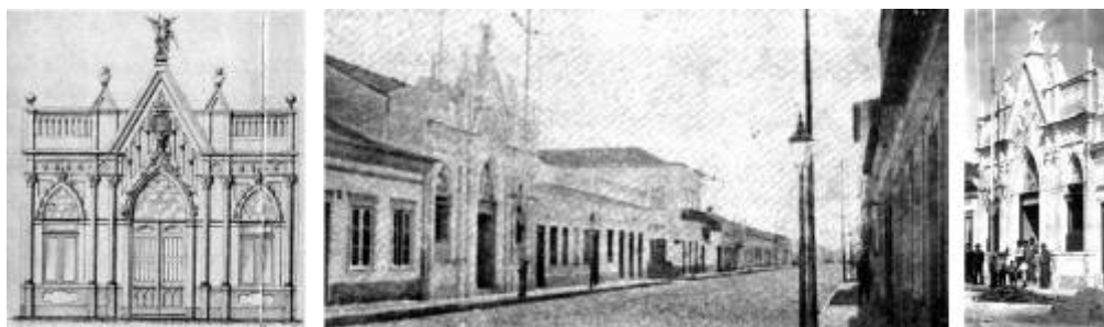
Figura 163: Congresso Português 1º de Dezembro Projeto de Caetano Casaretto, de 1895 (esquerda). A edificação localizada na rua Andrade Neves (centro). Fotografia da fachada (direita).
