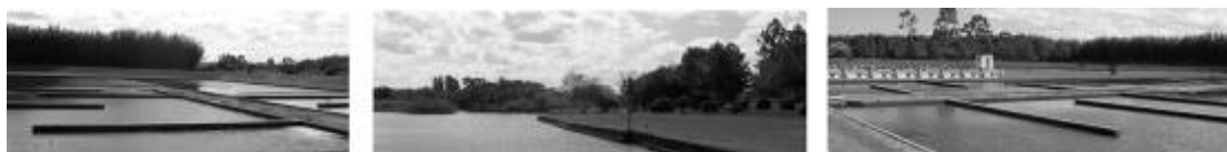
Figura 96: Arroio Moreira. Filtros (laterais) e contenção lateral da barragem (central) Fonte: acervo pessoal, 2005.
