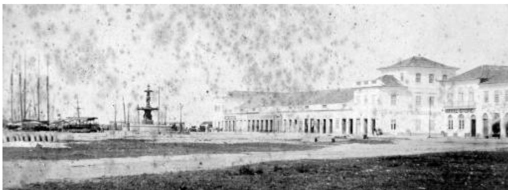
Figura 106: Praça Domingos Rodrigues, com o chafariz da Companhia Hidráulica Pelotense Fonte: Acervo fotográfico da Biblioteca Pública Rio-Grandense.
